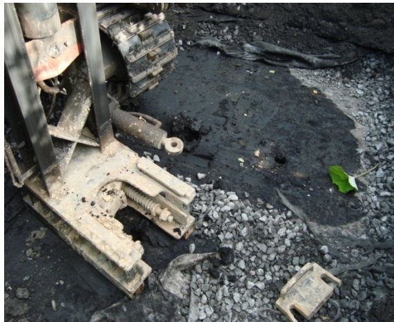
Figur 5.8 Provtagning av fast material på Gärstadverket. September 2010. Geotextilen har hindrat FSA och dränskikt från att tryckas in i varandra.
