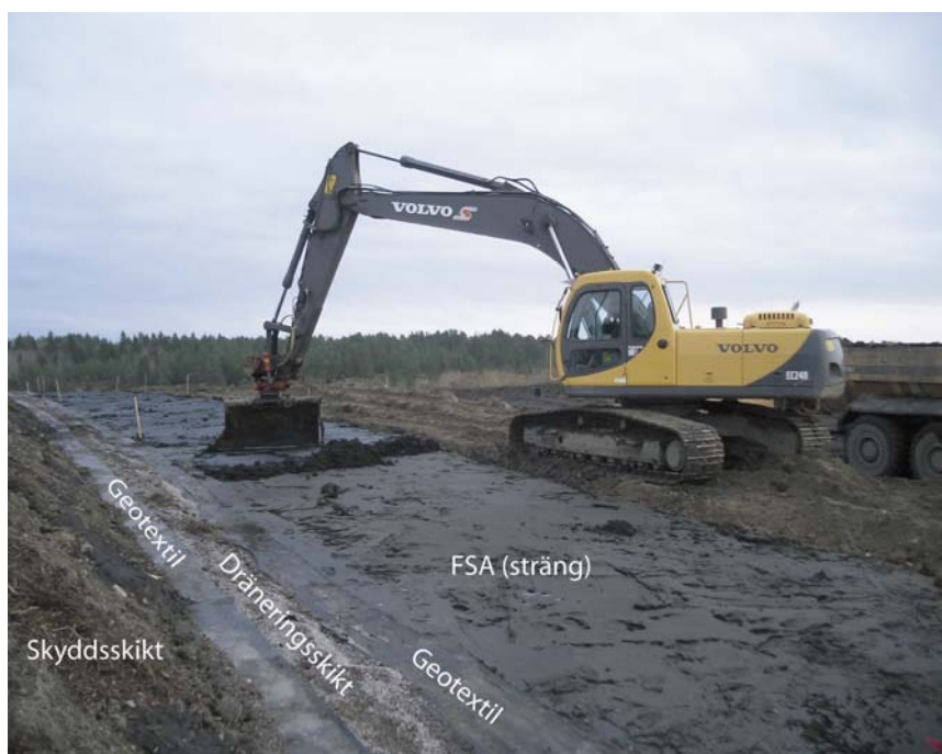
Figur 3.2 Utlagt FSA-, dränerings- och skyddsskikt, Lilla Nyby, Eskilstuna, [1].
