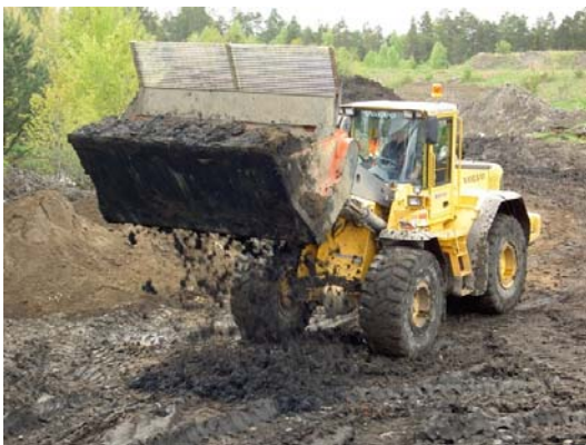
Figur 4.1 Blandning av FSA med ALU-skopa (Bild: Magnus Jakobsson, Eskilstuna Energi och Miljö AB)
