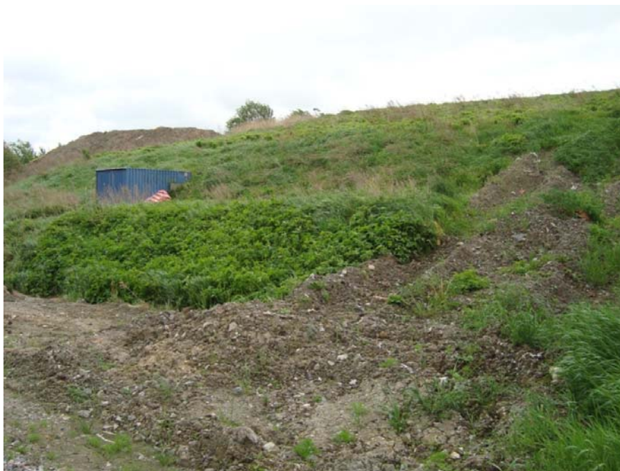
Figur 3.26 Provytan, tre år efter anläggning. Uppsamlingskärl för lysimetrarna finns i containern. (foto: Märta Ländell)
