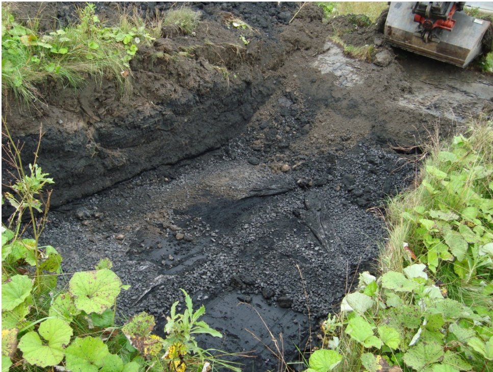
Figur 3.20 Framgrävning av FSA-skiktet. Notera geotextilen mellan drännskikt och FSA-skikt.
