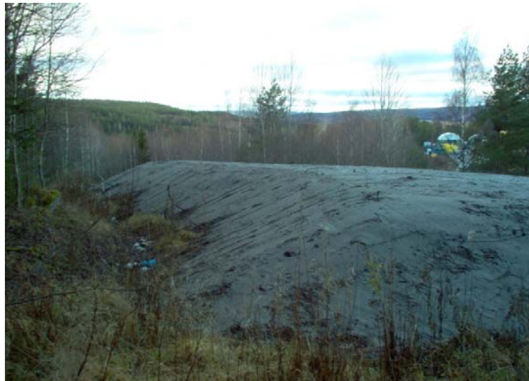
Figur 3.11 Pilotförsök med FSA som tätskikt på Blåbergets deponi. (Foto: Stina Lenströmer, Ramböll)[11]
