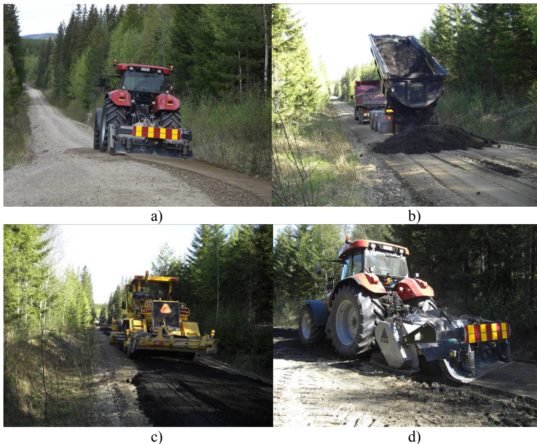
Figur 18. a) Befintliga vägen fräses upp. b) Utläggning av bindemedelsblandningen (recept B). c) Bindemedlet jämnas ut med väghyvel. d) Bindemedel och ballastfräses ihop.
