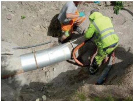
Bild 9a Plaströret dras bakåt
