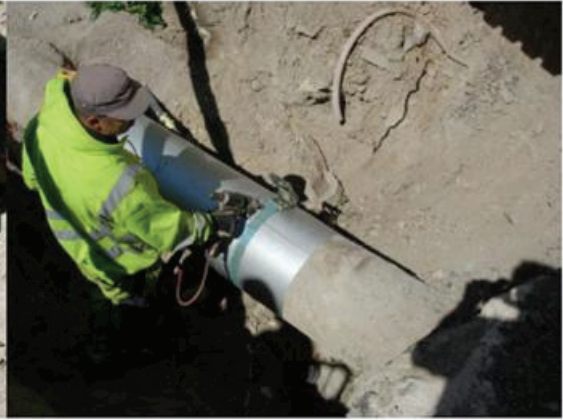
Bild 11b Insprutning utan plaströr
