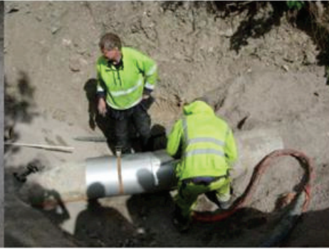
Bild 8b Plaströrets instick genom plåtsvepet
