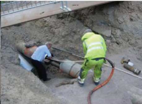
Bild 6b Plaströret förs in i kulvert
