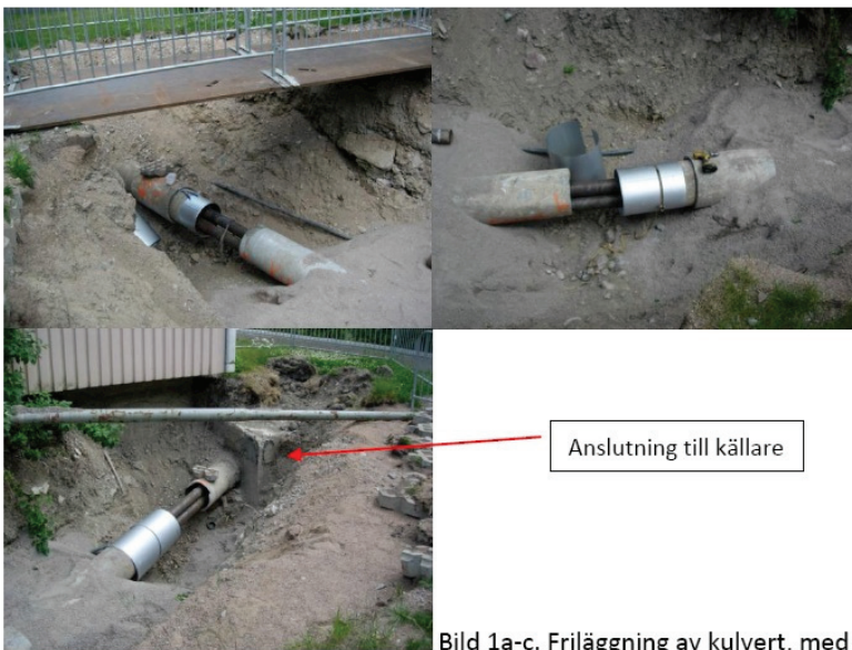
Bild 1a-c. Friläggning av kulvert, med utbytta rör
