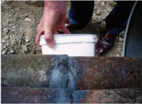
Bild 4 Skarv mellan nytt och gammalt rör
