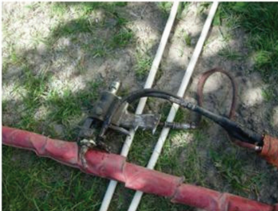
Bild 11a Svep monteras vid sista öppningen
