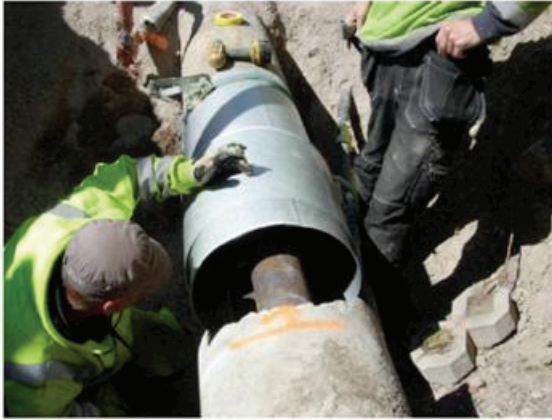
Bild 11a Svep monteras vid sista öppningen
