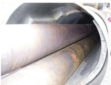
Bild 2a,b Äldre rör med isolering i bef kulvert
