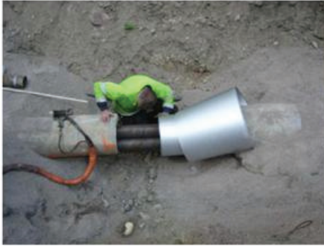
Bild 8a "Mellanöppningen" inspekteras
