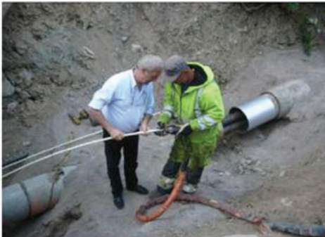
Bild 6a "Pistol" monteras mot kabelrör
