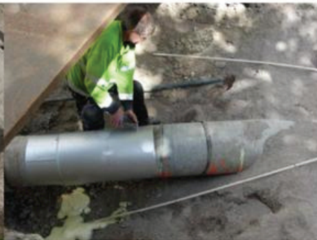
Bild 9b Slutmontage "mellanöppningen"
