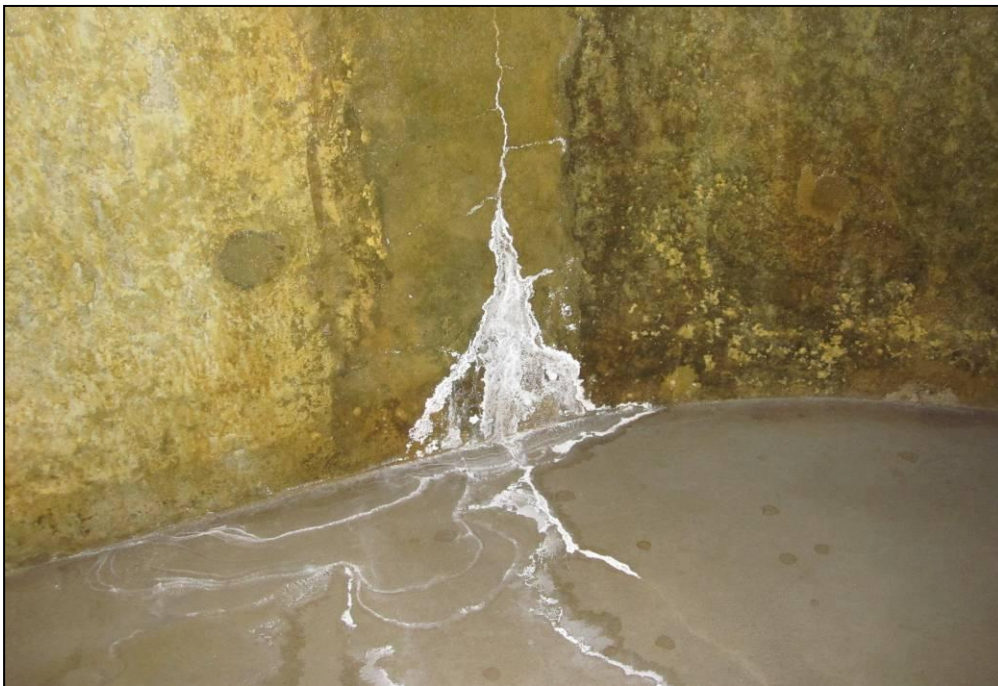
Figur 30: Urlakning av kalk.
