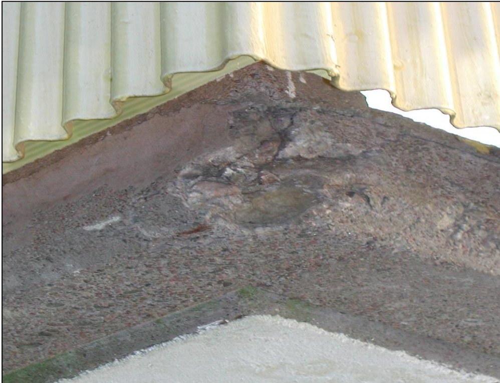
Figur 27: Betong i en balkongplatta utsatt för frysning i det plastiska tillståndet. Iskristallavtryck kan anas.
