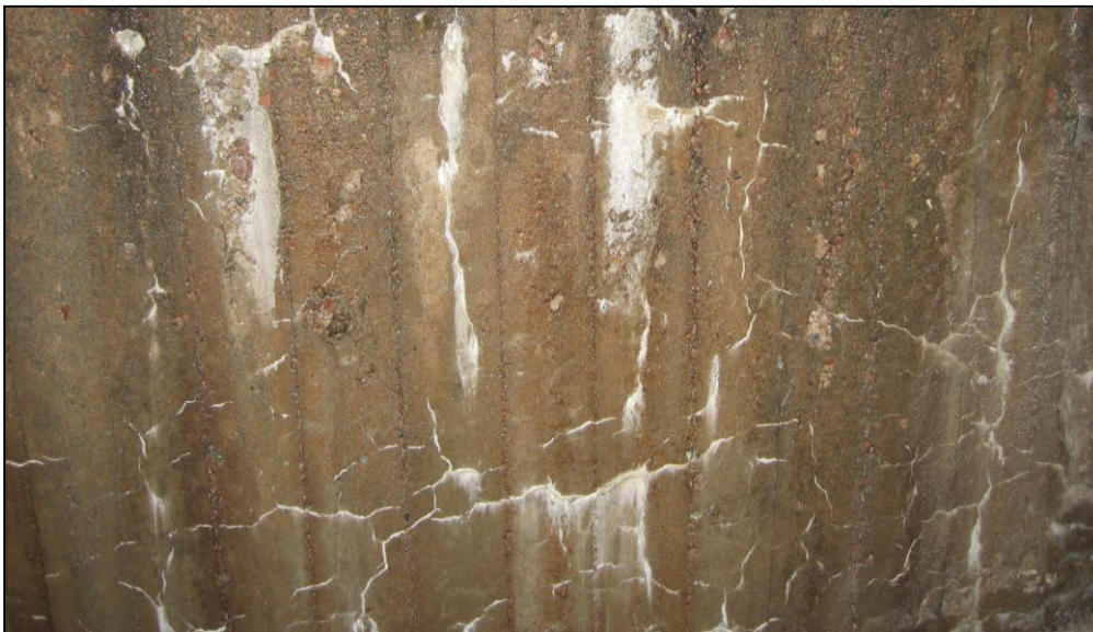
Figur 32: Sprickmönster orsakat av alkalikiselsyrereaktioner.
