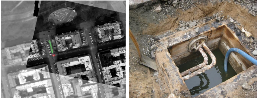
Figur 6.18. Vänster: Exempel på resultat som sammanställts. Den gröna och röda polygonen visar potentiella läckage. Höger: Resultatet efter uppgrävning.
