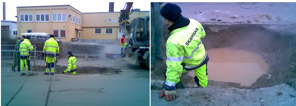
Figur 6.6. Uppgrävning av det varma området.
