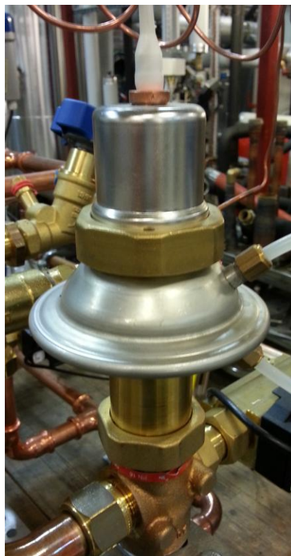
Figur 3 Danfoss AVTQ monterad i provningsriggen
