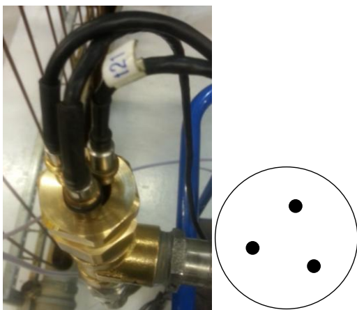
Figur 4. Montering av temperaturgivare.
