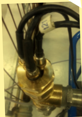
Figur 4. Montering av temperaturgivare.
