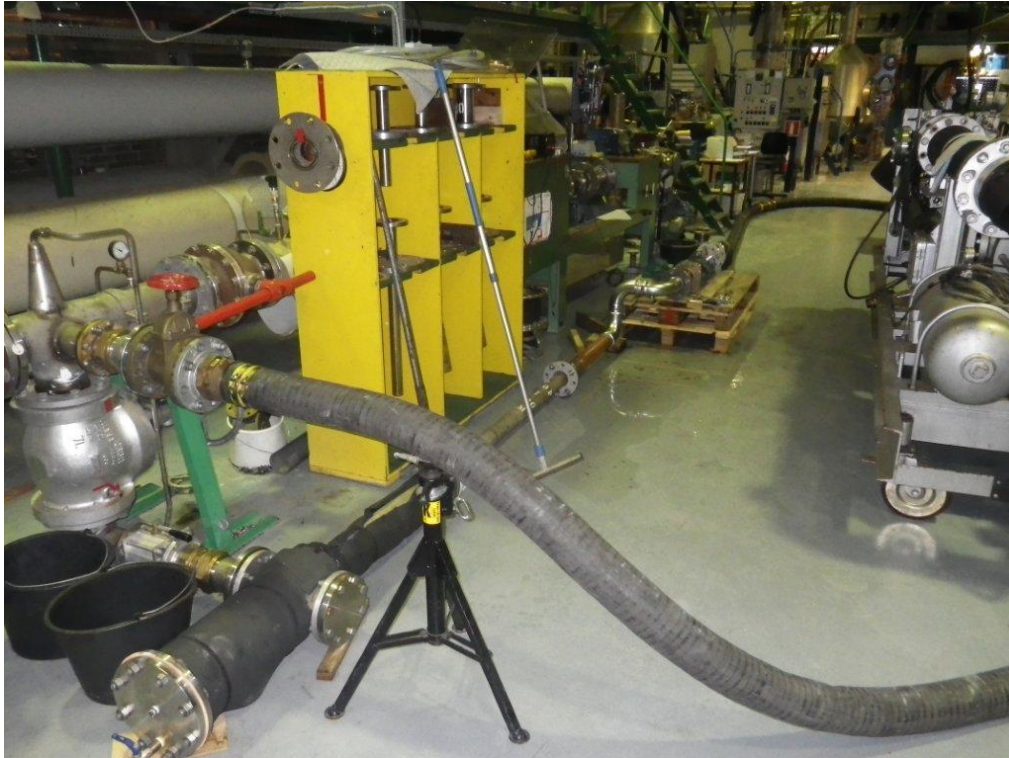
Figur 12. Provrigg för DN80-mätare, här med dubbel böj (skruvflöde) monterad.
