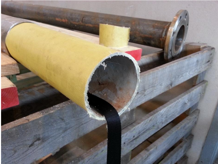
Figur 15. Installerat och uthärdat foder avskapat vid ena ändan.
