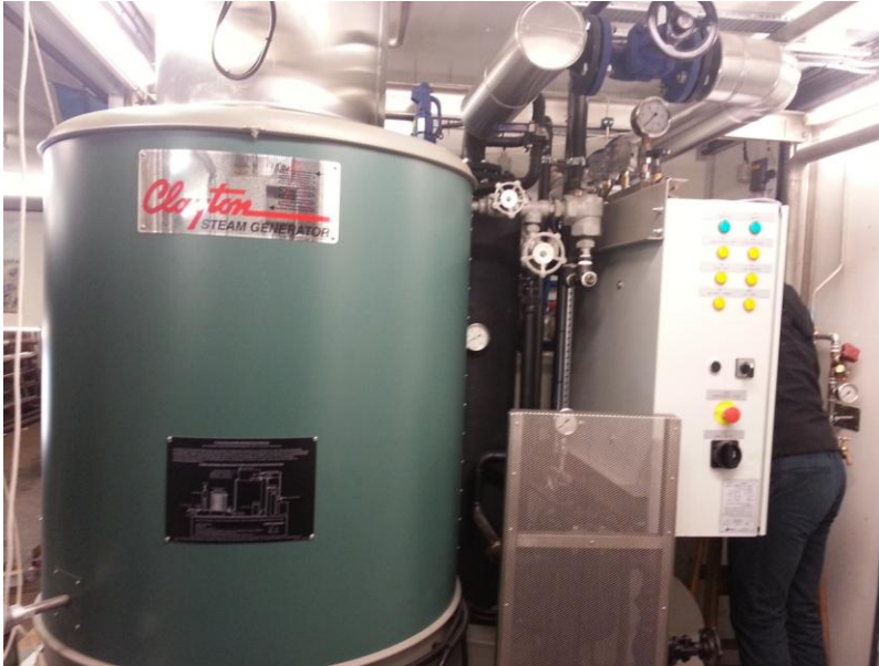
Figur 11. Ånggenerator installerad i enhet för relining.
