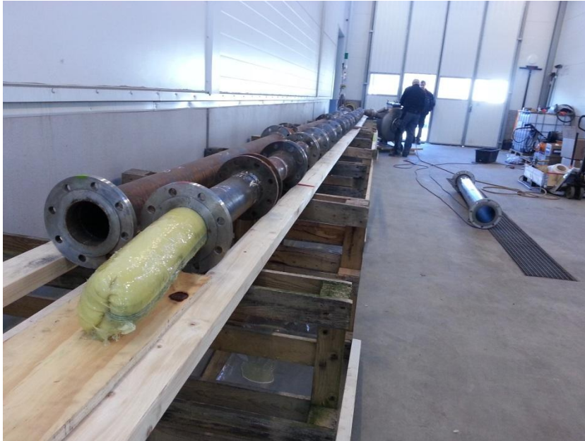
Figur 14. Ihopsatta rörbitar under relining.
