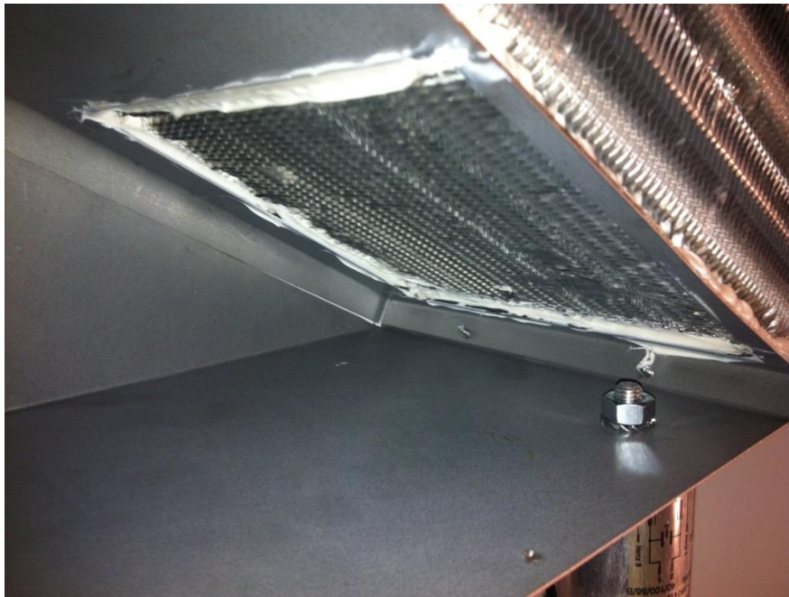
Bild 2. Appliceringen av silikon mellan ram och värmeväxlare.
