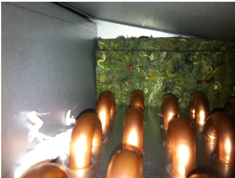
Bild 1. Den gröna ljudisolermattan som pressades in under värmeväxlaren.
