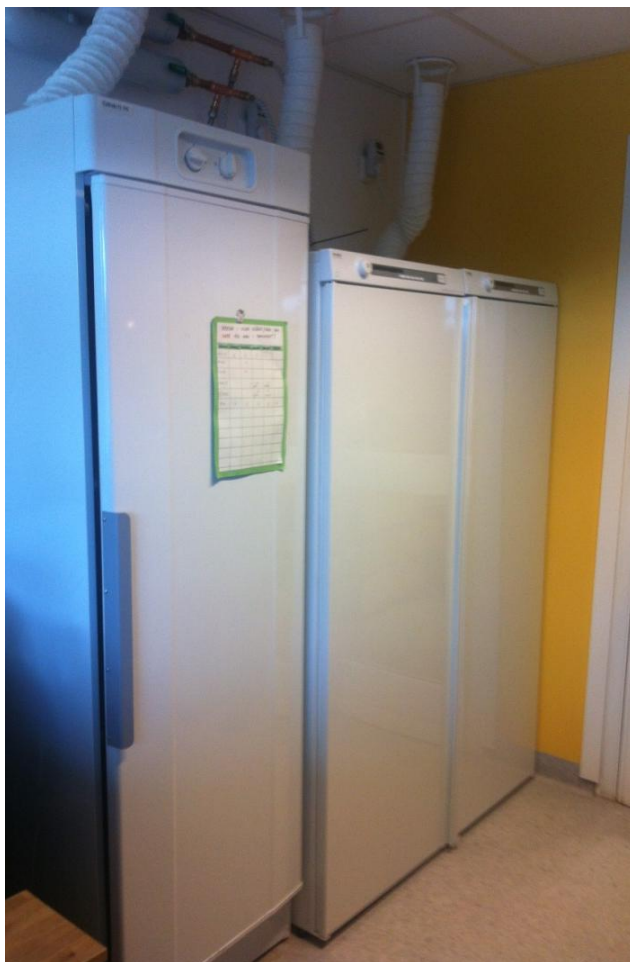
Figur 2.18. De två värmedrivna skåpen tillsammans med ett tredje elvärm torkskåp som inte kördes.
