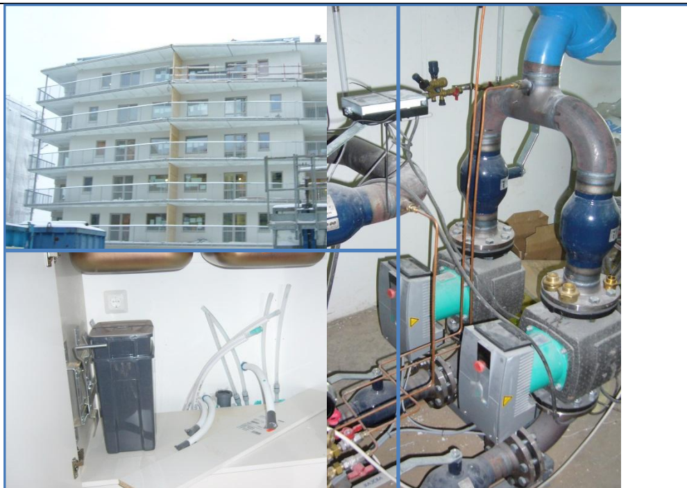
Figur 5.1. En av huskropparna i Råseglet i Västerås under uppförande där distributionssättet följer Västeråsmodellen (Figur 4.2), dock utan golvvärme i badrum. Till höger syns cirkulationspumparna för sekundärkretsen och nederst till vänster syns ett diskbänksskåp där ledningar för värme kretsen skall kopplas samman. Fotot togs i december 2012. Inflyttning sker i etapper under 2013.
