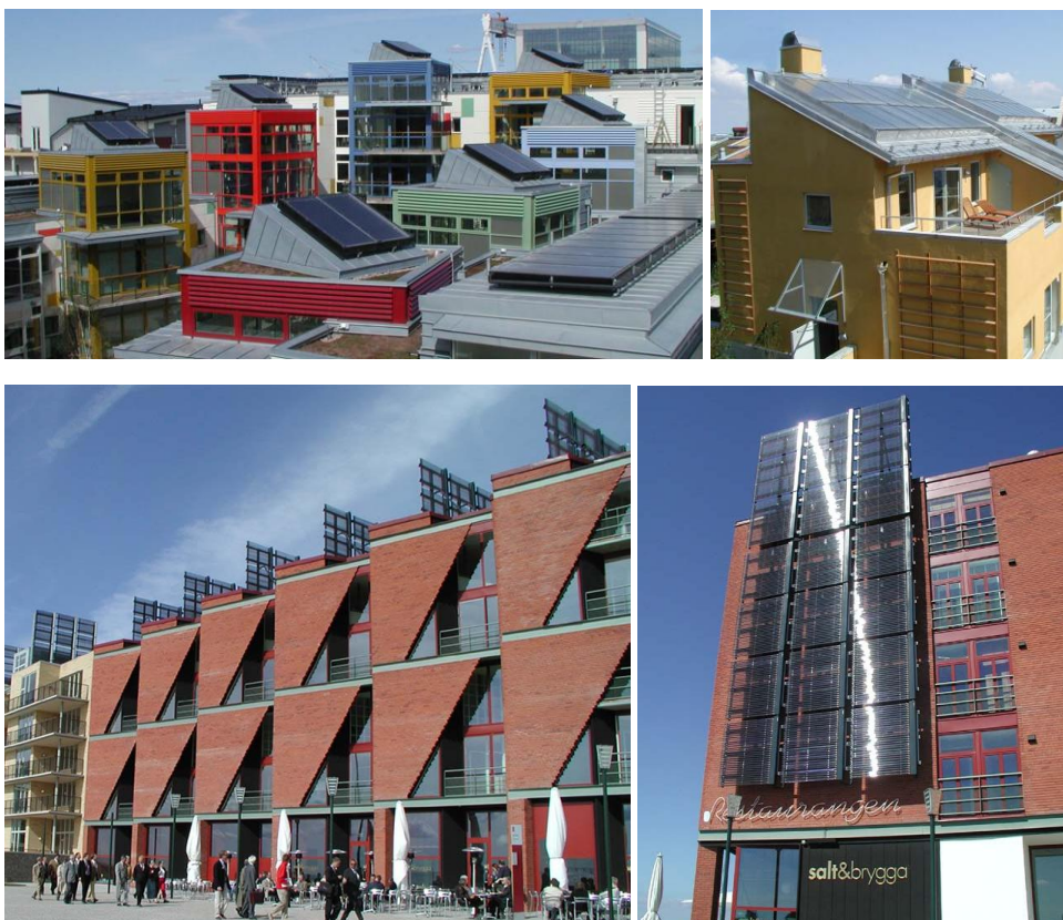
Bild 2. Solfångarmontage i Bo01, Västra Hamnen, Malmö.
