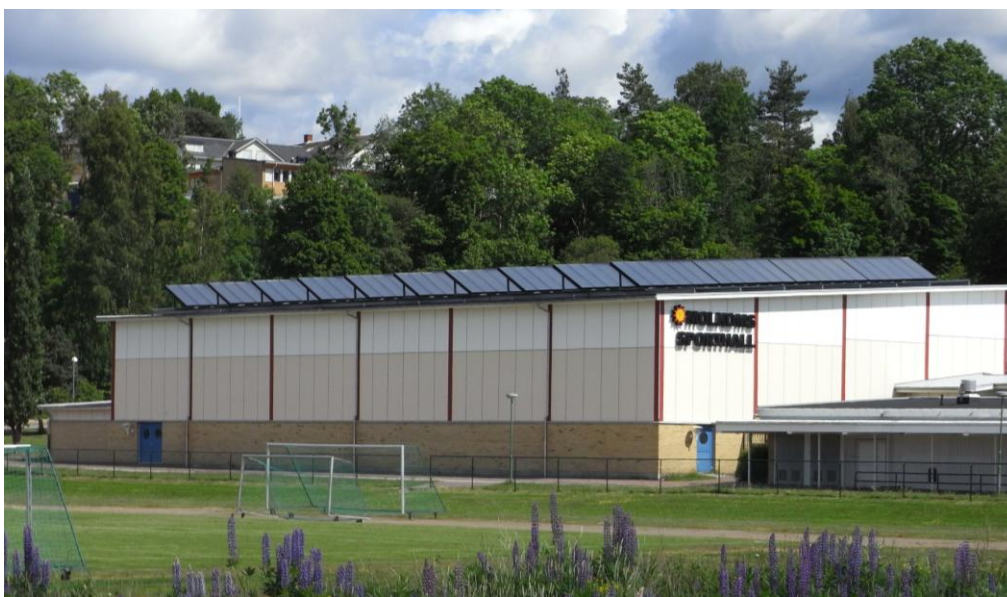
Bild 10. Solfångare på idrottshallen i Molkom, Karlstad.
