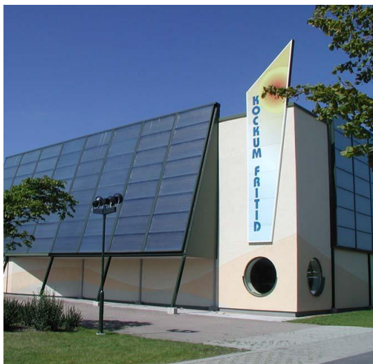
Bild 3. Solfångare monterade på fasader på Kockum Fritid, Malmö.
