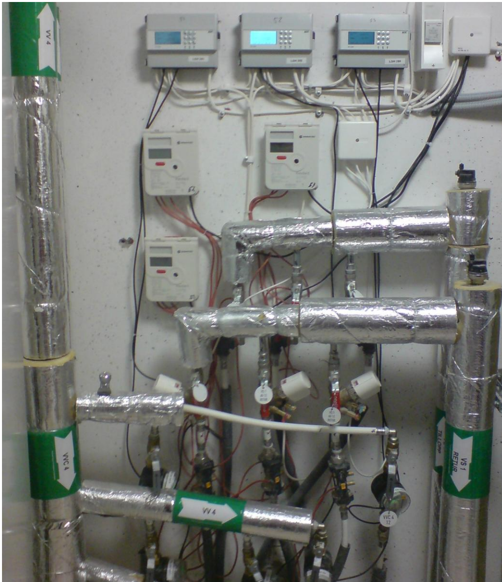
Figur 6. Mätarskåp för mätare till fördelningsmätning placerad i trapphall på varje plan.
