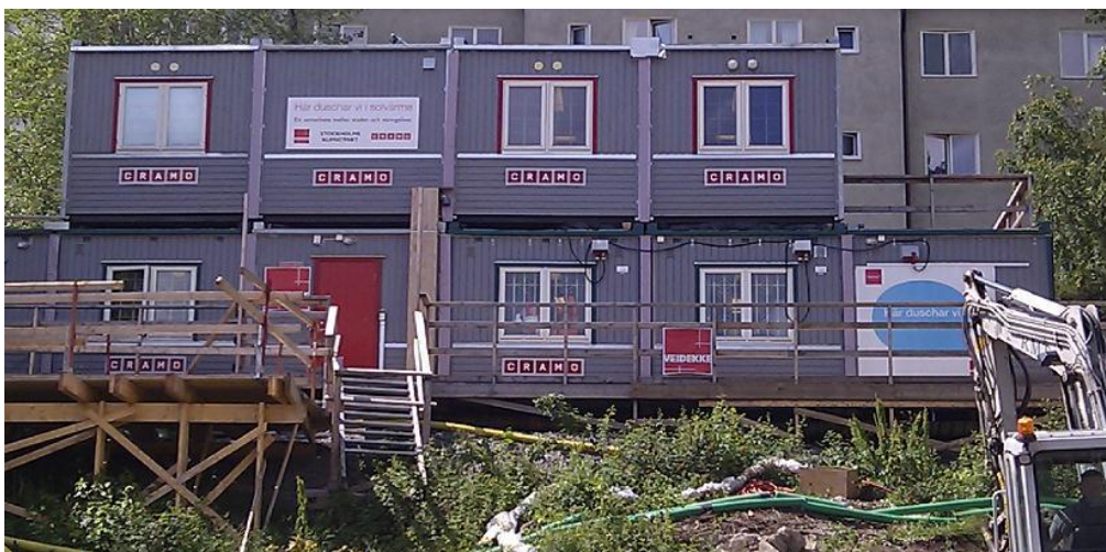
Figur 1. Uppställning av 10 byggbodar. Tätning mellan bodarna utförd.
