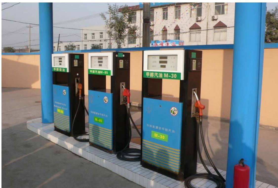
Figur 18. Bränslepumpar vid en kinesisk blandningsstation för metanol i drivmedel med M-30, M-85 och metanol i diesel. Källa: Tomas Ekbom, 2008.
