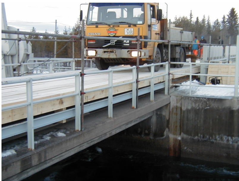
Provisorisk avlastning av bro över utskov
