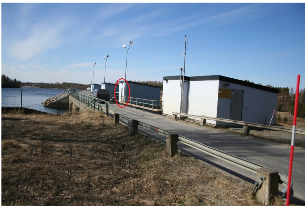
Spelhusens dörrar går direkt ut mot trafiken. Foto: Olle Mill.
