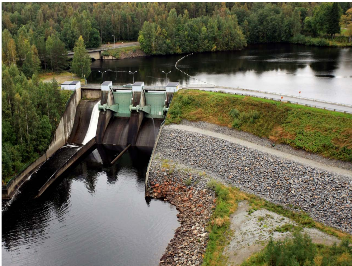
Ett fordon körde på det vänstra luckhuset.
