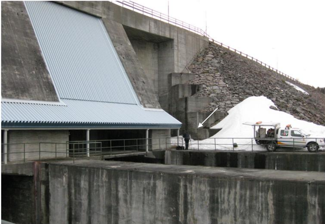
Figur 7. Gardikfors. Pilen markerar konstruktionsdelen som proverna har tagits från.
