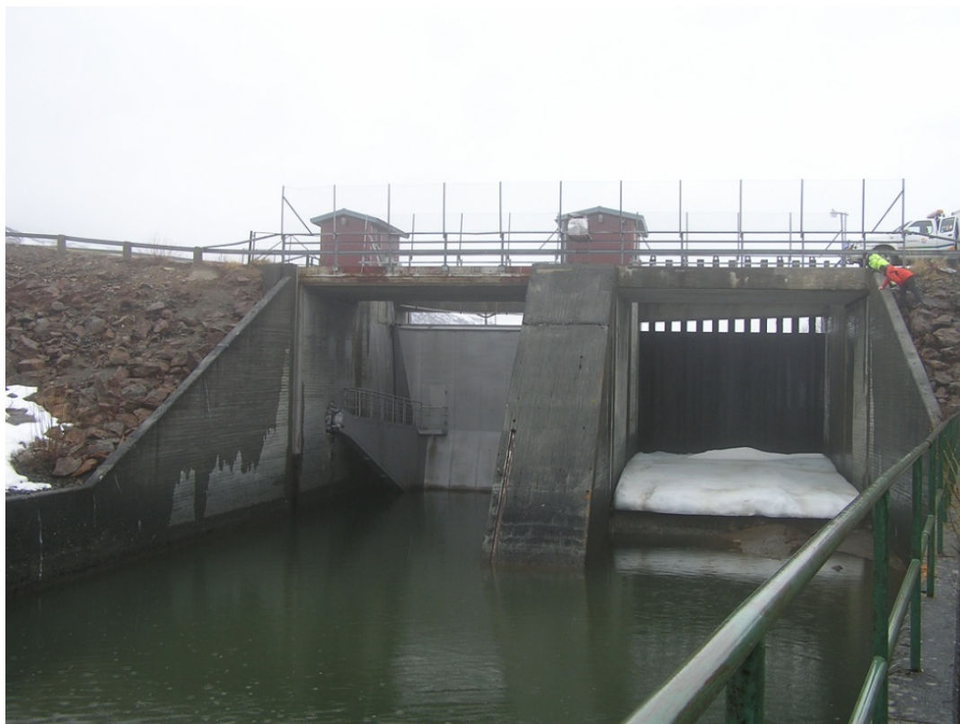
Figur 8 Översiktsbild av Överumans regleringsdamm.
