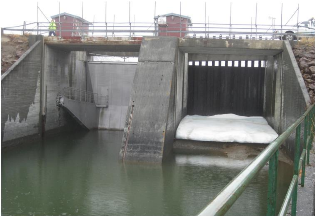
Figur 13. Överumans regleringsdamm. Pilen markerar konstruktionsdelen som proverna har tagits från.
