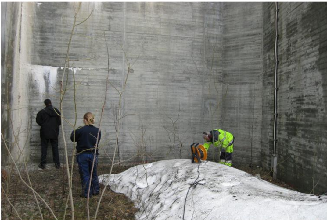
Figur 8. Gardikfors. Pilen markerar konstruktionsdelen som proverna har tagits från.
