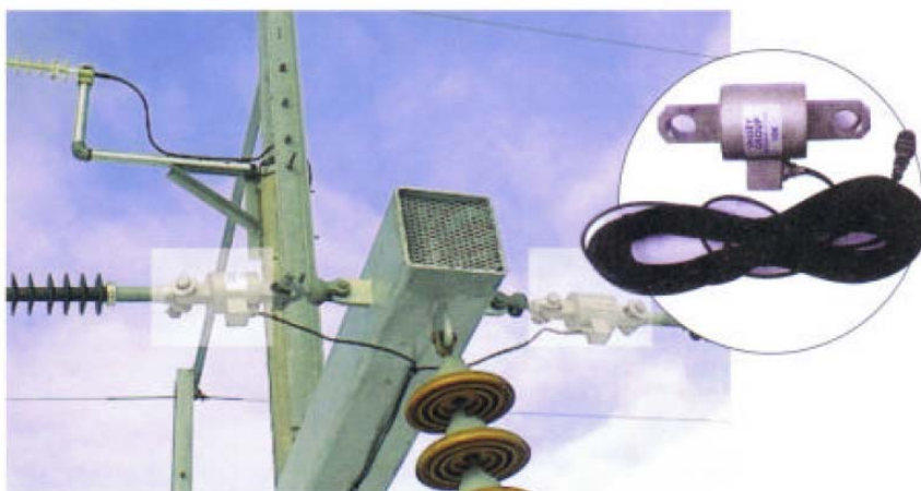
Figur 17 Installerad lastcell [18].
