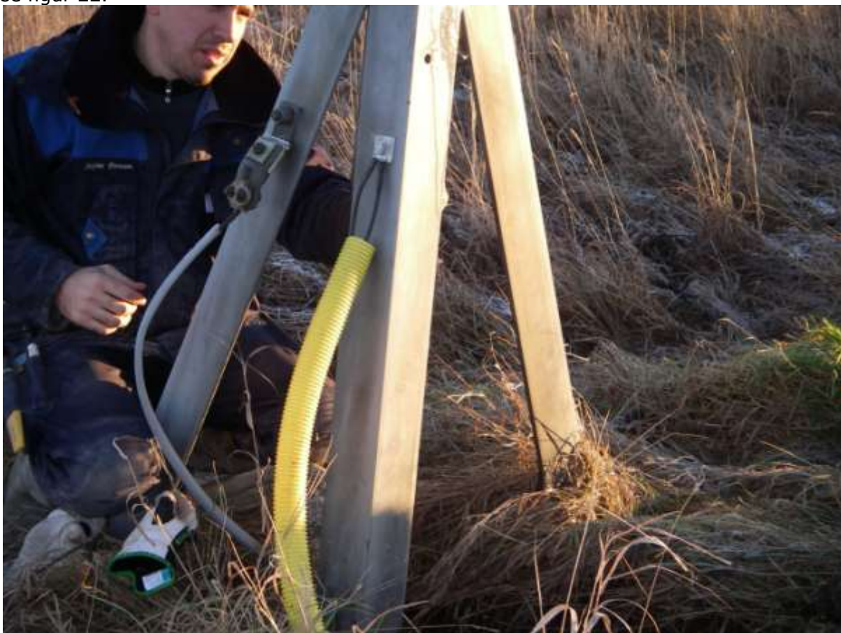
Figur 22. Montering av kablar i stolpbenet.
