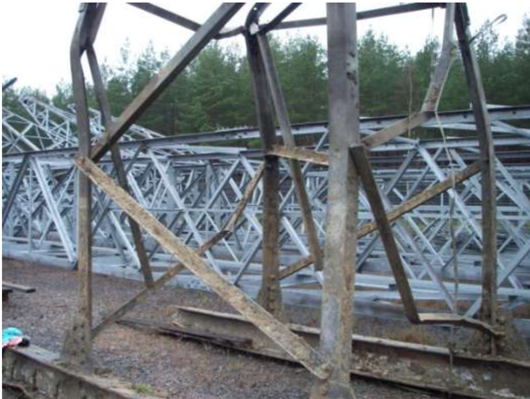
Figur 6. Stolpben bestående av ramstänger, diagonaler och balkar.
