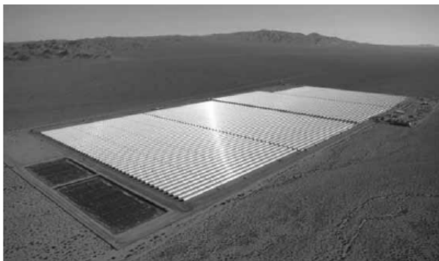
64 MW anläggning i Nevada, Boulder City. (Källa: Acciona Solar Power)
