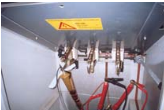
Figur 5 Bilden visar hur signalen appliceras på en enfaskabel via en metallisk kona för god signalöverföring.
