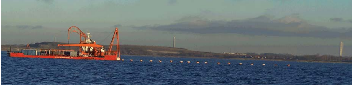
Figur 9. Uppblåsbara luftkuddar användes för att flotta kabeln till land
