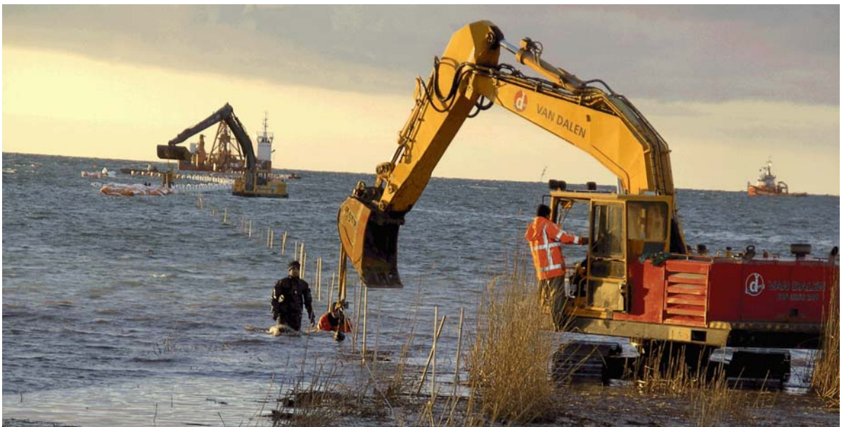
Figur 10. Flottning av kabel med hjälp av grävmaskiner och motorbåt
