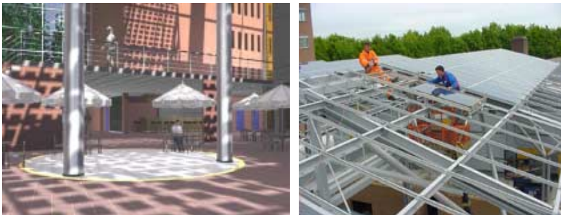
Sportcentret i Wageningen i Holland, semitransparenta solceller totalt 282 kWp
