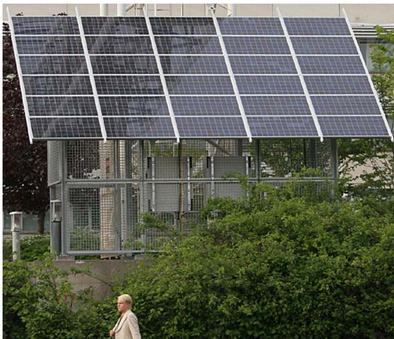
Figur 16 Nätanslutet solcellssystem för elförsäljning. Anläggningen finns på parkeringen på ABB AB, Corporate Research, vid E18 i Västerås.
