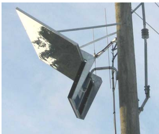
Figur 7 Reflektor med konsoler och stagning
