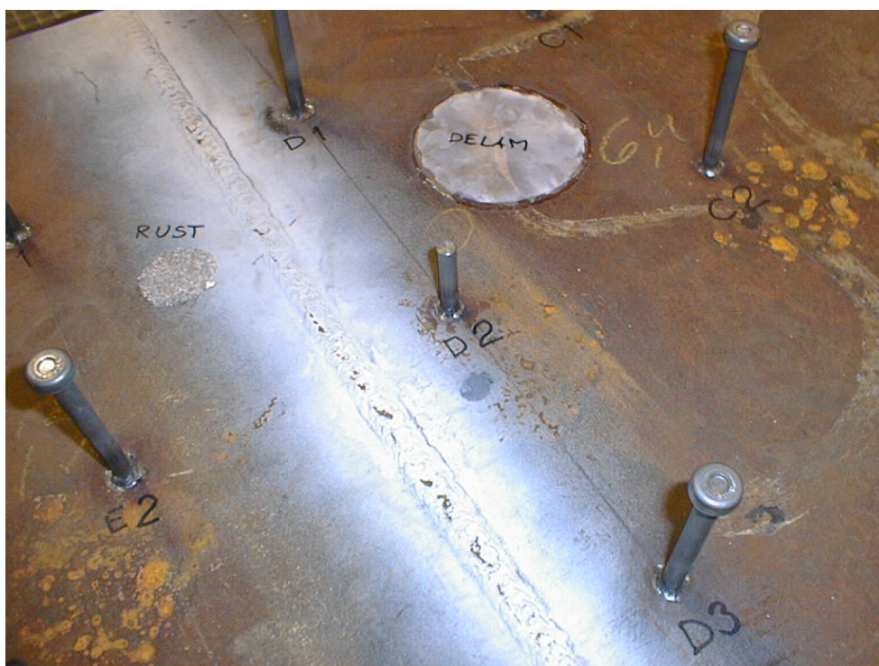
Figur 2. En cirkulär delaminering i fältet CD12. Notera målarfärgen målad i form av en 5:a. Stålpinnarna är sk "studs". Rosten simuleras med hoplimmad sand – "RUST".
