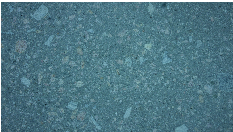
Figur 8. Resultatet av nedslipningen är en jämn betongyta nästan utan porer och ojämnheter.
