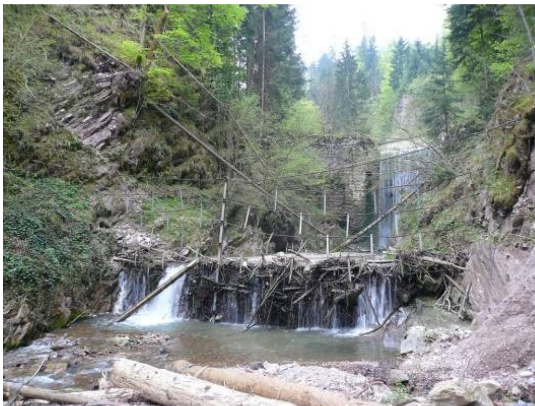
Figur 3. Nät vid mynningen av mindre tillflöde, Österrike 2007. (erhållet av Helmut Czerny på Österrikes nationella dammsäkerhetsmyndighet via Maria Bartsch, Svenska Kraftnät)
