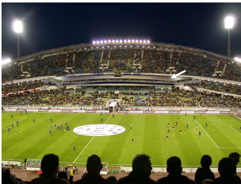
Figur 1. Illustration av VIP-läktaren på Ullevi med solceller på taket. Källa: ABAKO Arkitektkontor AB
