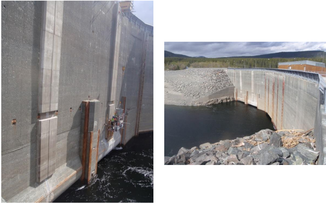
Figur 4.10 Bilderna visar pågående reparationsarbete av dilatationsfogarna på dammen i Gardiken och dess slutresultat.
