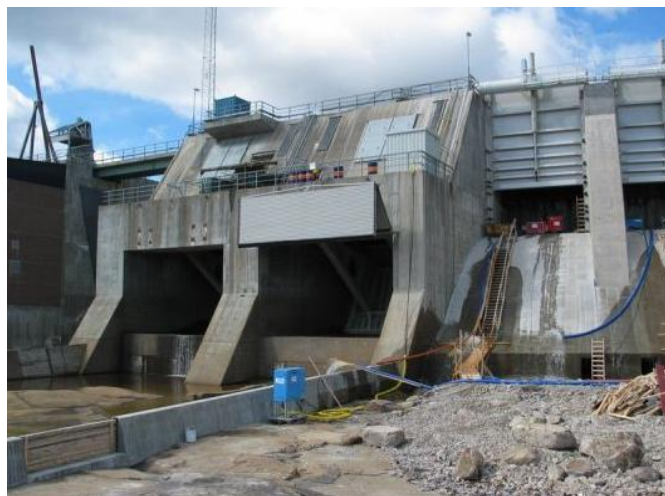
Figur 4.6 Till höger av bilden visas ombyggnationen av reservutskoven på Svegs kraftverk. Bildkälla: KFS AnläggningsKonstruktörer AB [23].
