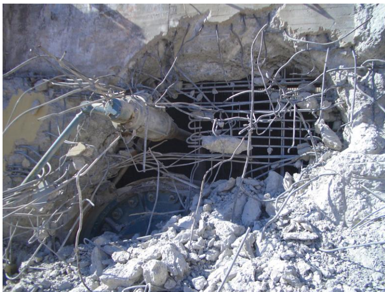
Figur 2.2 Samma sumpvägg som i Figur 2.1 ovan, denna bild visar generatorinfästningen och efter delvis demolering genom sprängning. Bilden gör det också möjligt att få en känsla för armeringsmängdens betydelse för rivningsarbetet
