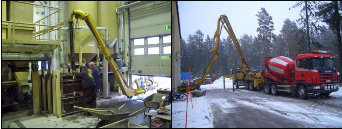
Figur 5.1: Uppställning och utförande av gjutning av vad som beskrivs som "form 1" i Vägverkets publikation [9]
