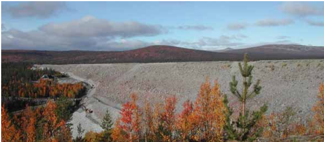
Figure 27 – The Seitevare dam
