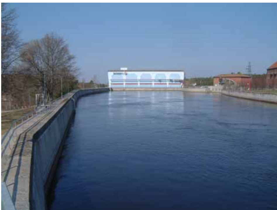
Figur 3.1 Inloppskanalen med vänster kanalmur och det nya aggregatet G6 till höger i bild.
