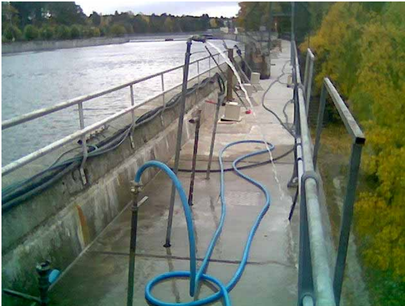
Figur 5.3 Spolning med samband mellan två hål
