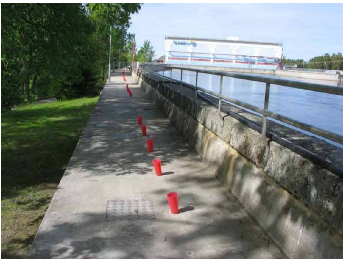
Figur 5.5 Borrhål i väntan på injektering
