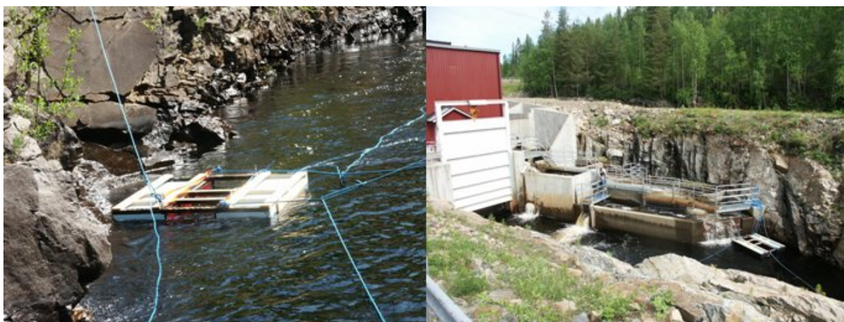
Figur 9: Flytande lockvattenanordning vid Hednäs kraftstation i Åbyälven.
