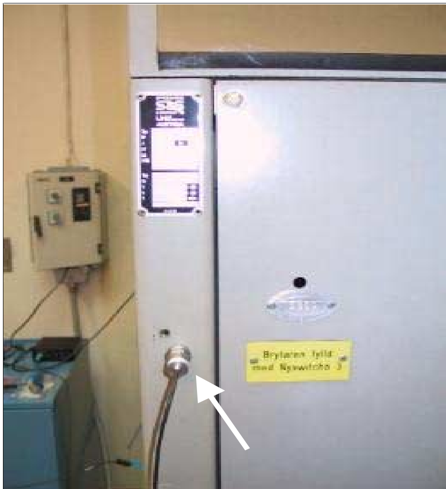
Kelmans accelerometer var placerad vid pilen. Motsvarar placering B enligt kap. 5.3.1 i rapporten. Bild: Vattenfall Utveckling.
