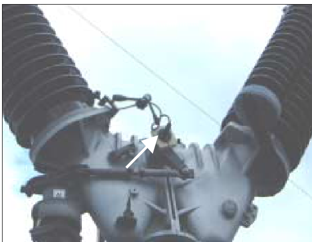
Figur 5.12 - Mätning av rörelsen i mekanismhuset med roterande rörelsegivare (Programma).
