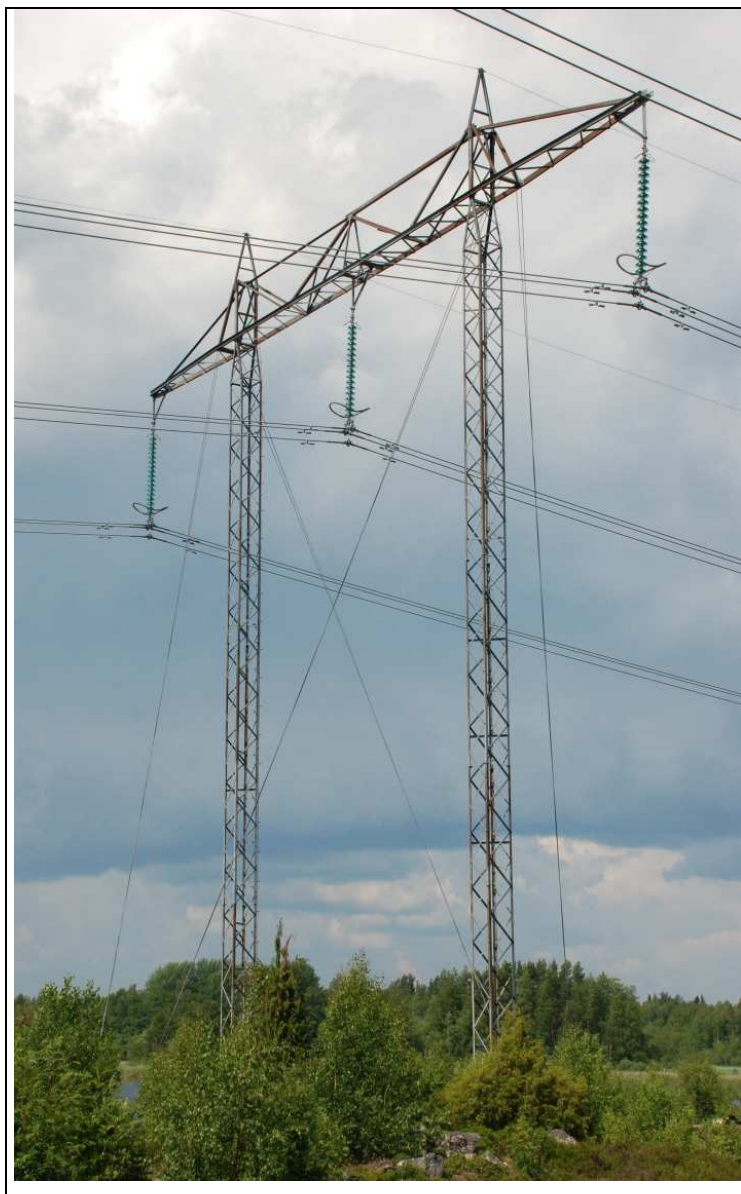
Figur 45. Stolpe för 400 kV. Mätningarna genomfördes längs "insidan" av det vänstra stolpbenet, mot mittfasen.
