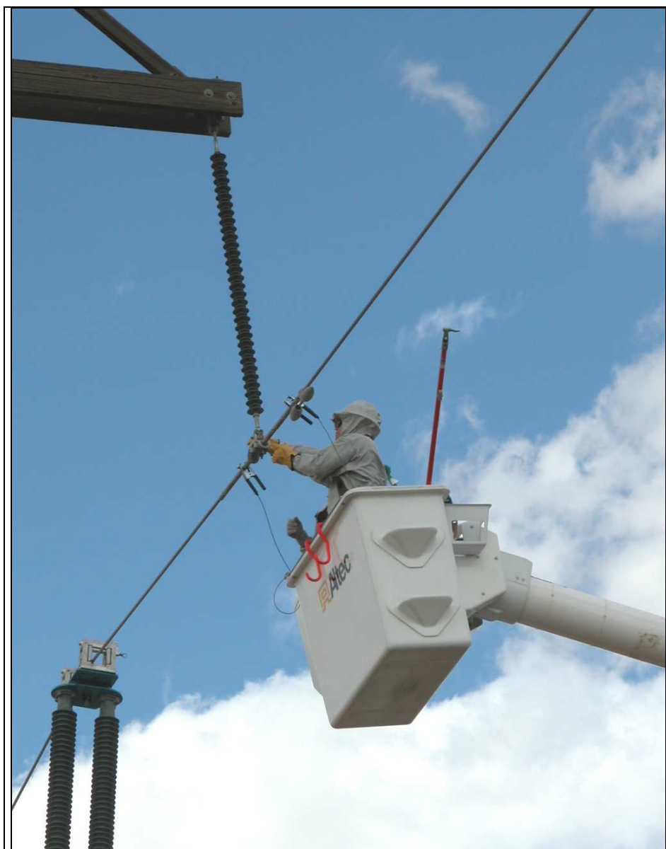
Figur 3. Barhandsarbete från lift med isolerad bom. Montören bär en ledande dräkt och har skydd för huvudet. I detta fall står han på faslinans "utsida", men bomen kan manövreras så han även kommer åt mittfasen. Bilden tagen i samband med ESMO-konferensen i Albuquerque, New Mexico, 2006.
