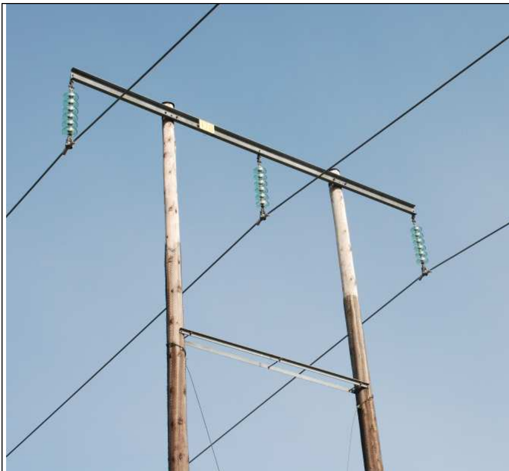
Figur 43. Stolpben med nät, invändigt krysstag och brygga. E-fältet mättes längs det vänstra stolpbenet.
