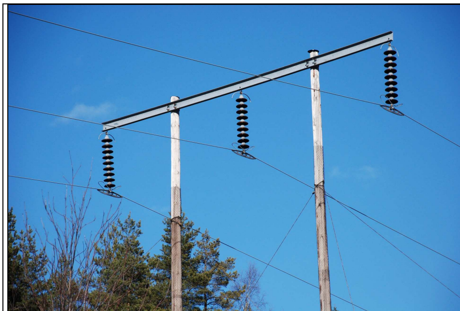
Figur 7. Ledning för 130 kV. Bilden motsvarar beräkningssnitt 130_4_A.
