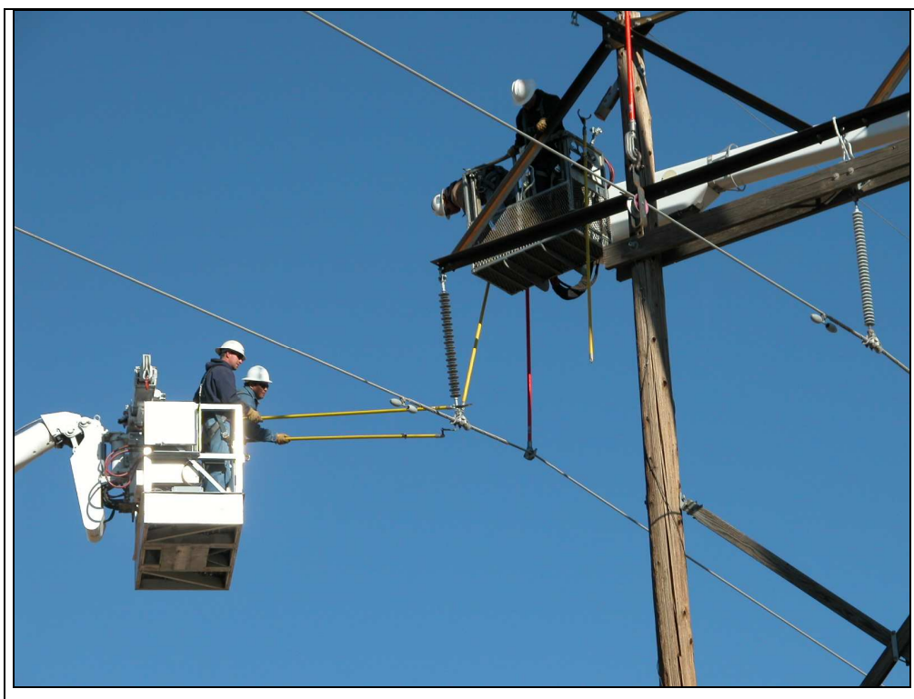
Figur 2. Arbete med isolerstång från skylift med isolerad bom. I detta fall arbetar man både från ytterfasens "utsida" och en korg i nivå med regeln.
