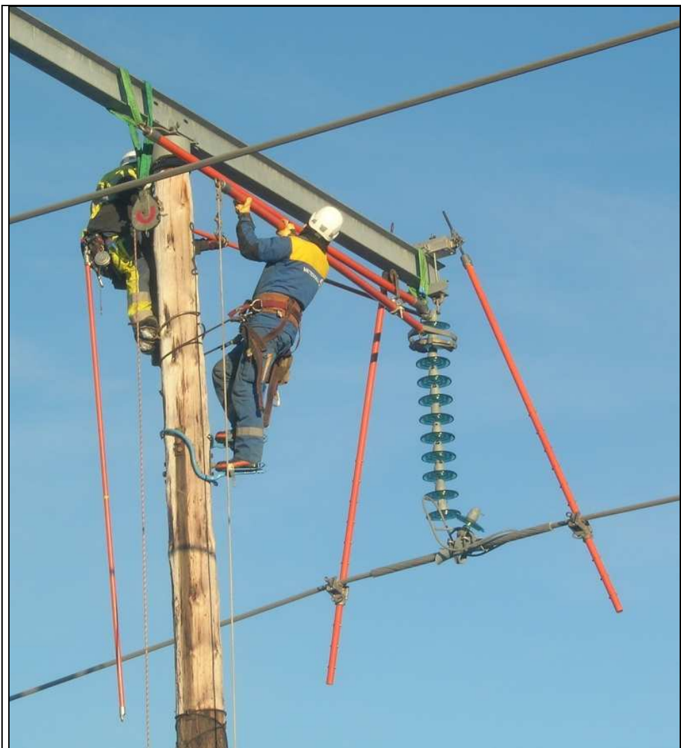
Figur 5. Byte av isolatorkedja på en 220 kV ledning. De två montörerna har nu flyttat sig något uppåt längs stolpen. Personal och plats som tidigare bild.
