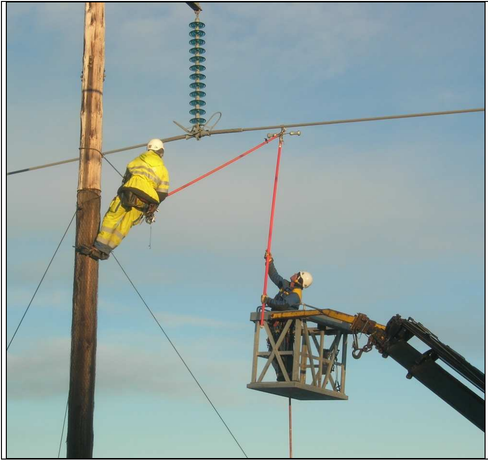
Figur 6. Personal från Vattenfall Service monterar vibrationsdämpare på en ledning för 220 kV. Arbetet sker med isolerstång från stolpen och från en korg monterad på en hydraulbom på en grävmaskin. Eftersom dämparen skall placeras på något avstånd från isolatorn får montören i stolpen luta sig bakåt. Samma arbetsplats som de två tidigare bilderna.
