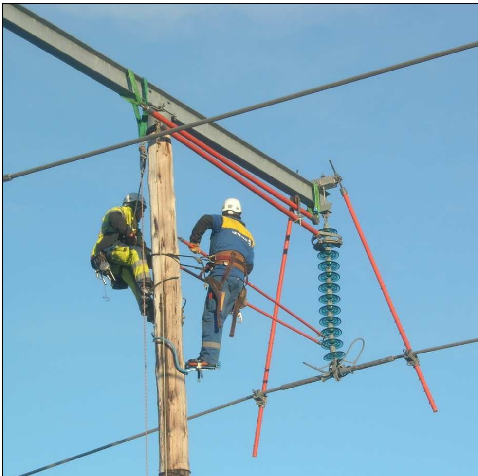
Figur 4. Personal från Vattenfall Service byter isolatorkedja på en 220 kV ledning. Arbetet sker med isolerstång. Montörerna står i stolpen och lutar sig något utåt och mot kedjan. Bilden tagen i trakten av Sundsvall i samband med en demonstration av metoden.
