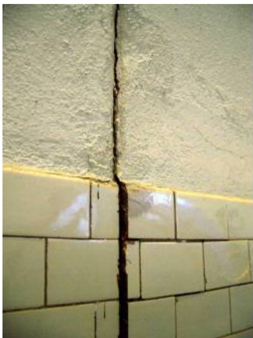
Figur 4.2 Dilationsfogen i maskinsalen, nedströms vägg.
