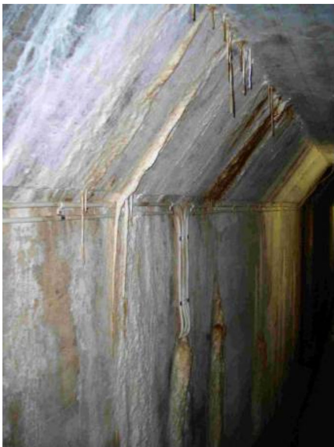
Figur 4.16 Extremt mycket kalkutfällningar kommer ur kabelrör i nedströms vägg.
