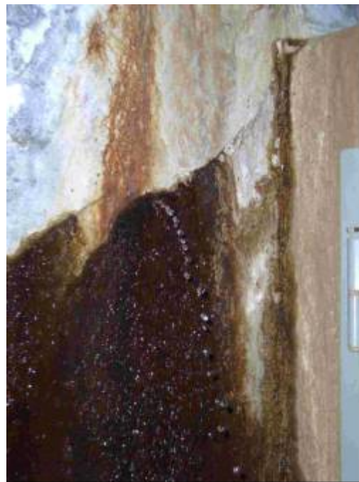
Figur 4.11 och 4.12 Diagonala sprickor med läckage, kalkutfällningar och eventuella korrosionsprodukter. Större läckage ur en spricka i väggen mot inloppet för system 5.
