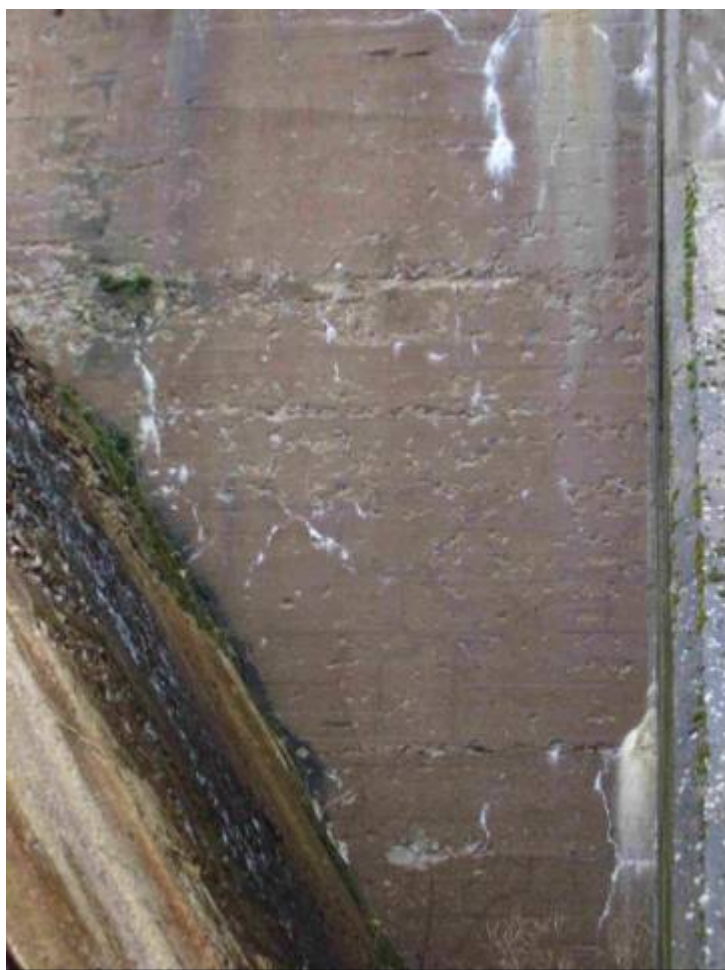
Figur 2.20 Avskalning längs pelarsida.
