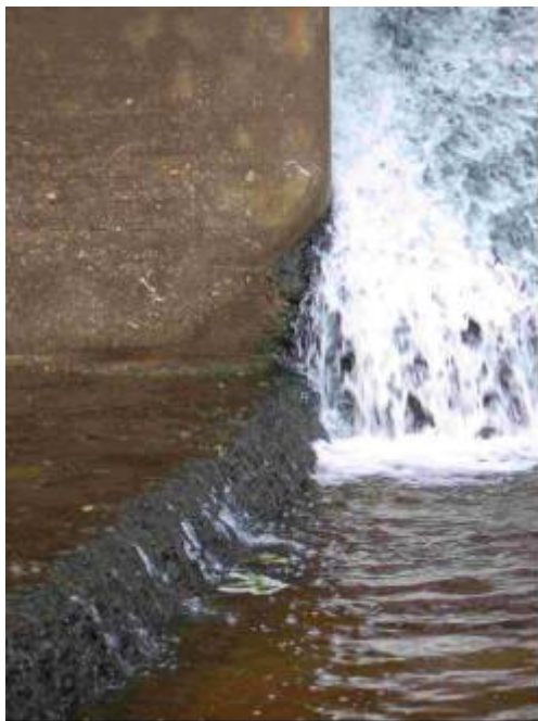
Figur 2.21 Erosion i pelarsida längs skibord.
