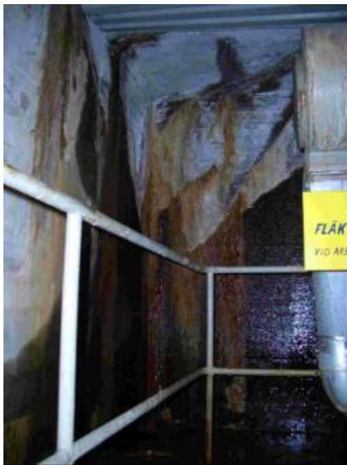
Figur 4.11 och 4.12 Diagonala sprickor med läckage, kalkutfällningar och eventuella korrosionsprodukter. Större läckage ur en spricka i väggen mot inloppet för system 5.
