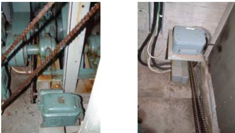
Figur 3.6 Gränslägen som påverkas av spelmaskineri via kedja och drev.
