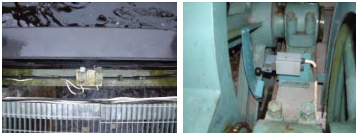
Figur 3.3 Gränslägen som påverkas av luckans rörelse (vänster) respektive gränsläge som påverkas via spelmaskineri (höger)
