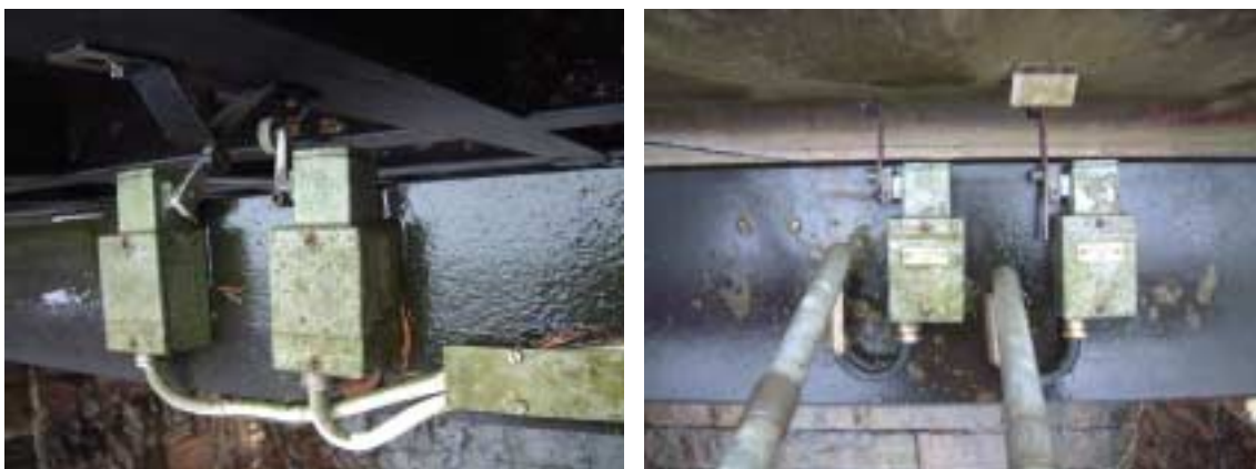
Figur 3.8 Gränslägesbrytare med vipparm och rulle respektive justerbar vipparm och rulle.
