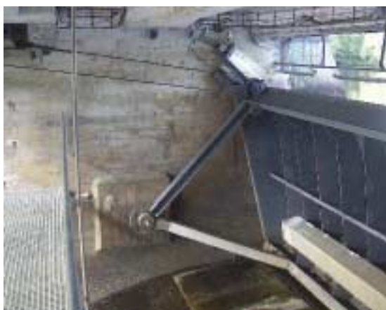
Figur 3.2 Utskovslucka med linspel.
