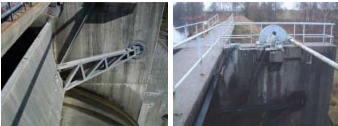
Figur 3.1 Utskovsluckor med kuggstångsspel.
