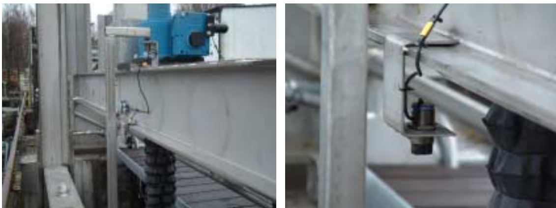
Figur 3.12 Induktiva givare och påverkansdon.
