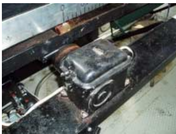
Figur 6.2 Gränsläge stängd utskovslucka.
