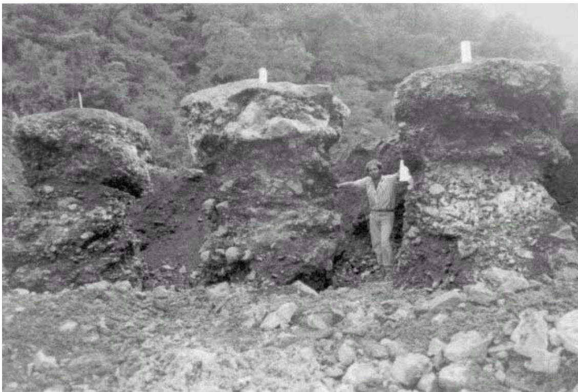
Figur 9. Provpelare som grävts fram i samband med förundersökningar för att bestämma hur Jetpelare ska produceras.
