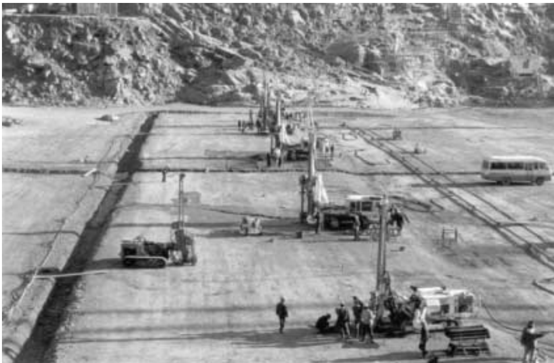
Figur 10. Jetinjektering i Ertan-dammen, Kina.
