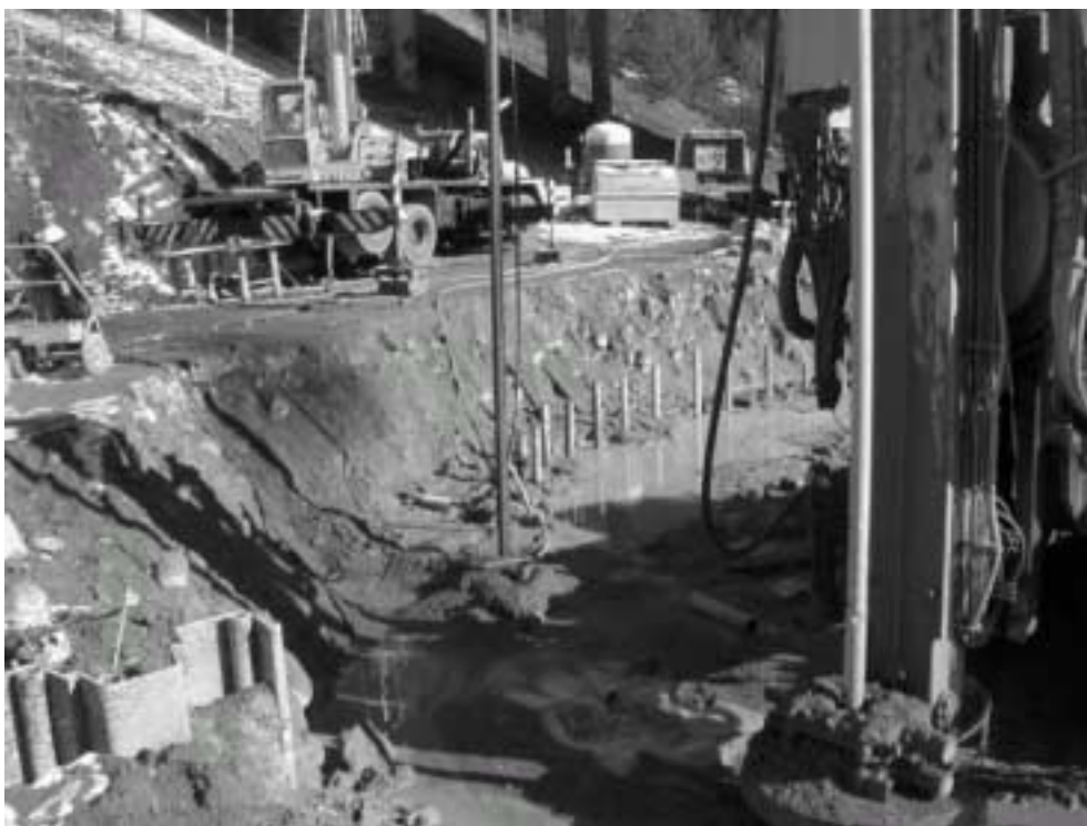
Jetinjektering för fundament vid bro över Södertälje kanal.
