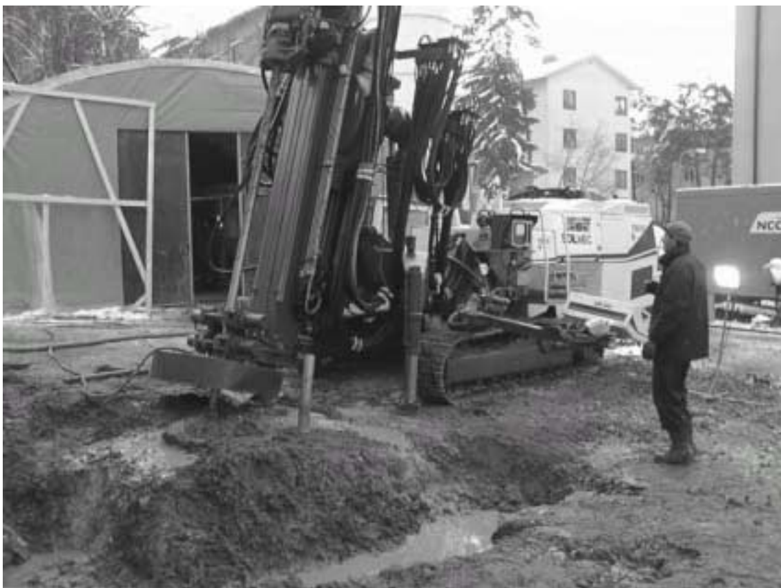
Figur 2. Jetinjektering ned till 10 – 20 meter med konventionell borrhigg.
