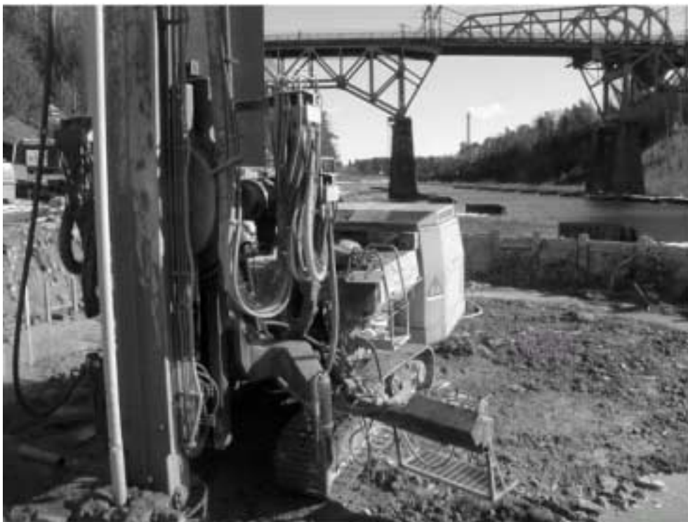
Jetinjektering för fundament vid bro över Södertälje kanal.
