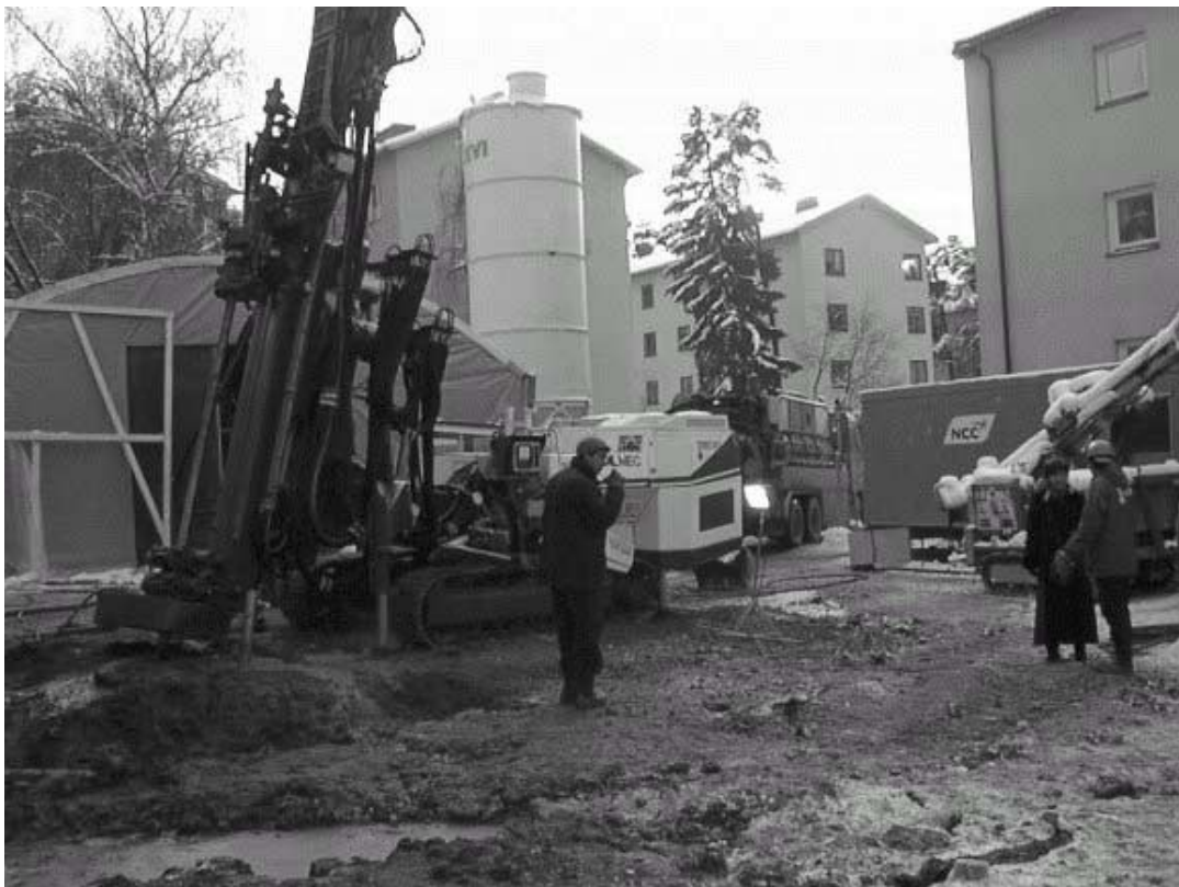
Figur 8. Utrustning för Jetinjektering vid Södra Länken i Stockholm
