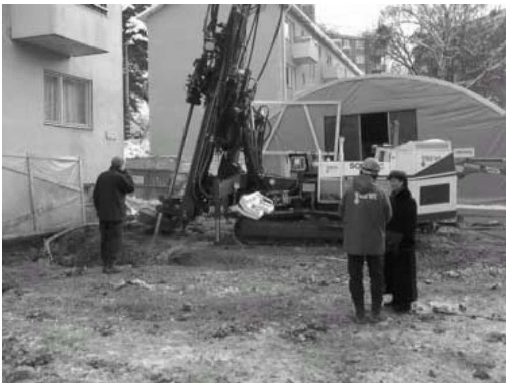
Jetinjektering av marken ovanför Södra Länkens tunnel, Stockholm.
