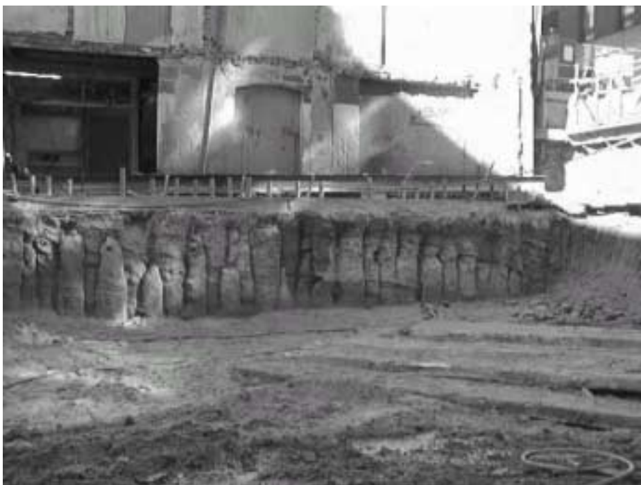
Jetinjektering som grundförstärkning, Stockholm.
