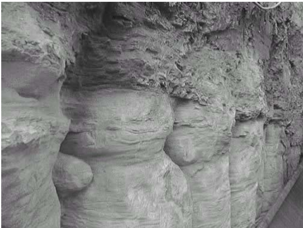
Figur 4. Färdiga Jetpelare. Bilden visar Jetpelare som utförts som markförstärkning under ett hus. Pelarna har därefter schaktats fram i samband med byggnation på angränsande fastighet.
