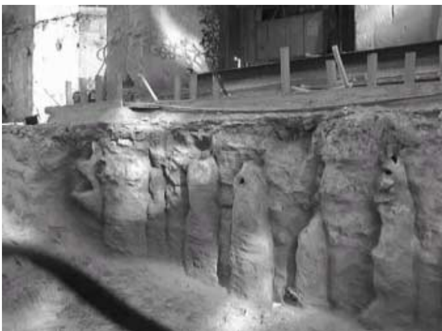
Jetinjektering som grundförstärkning, Stockholm.
