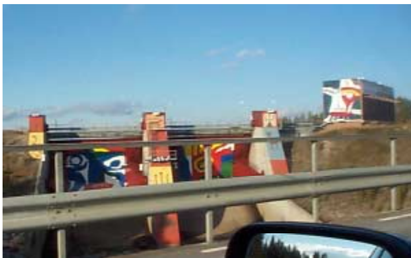
Foto taget vid Akkats kraftstation längs Luleälven.
