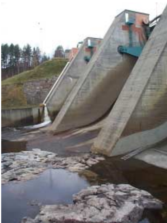
Bild 3.3.1. Utskoven vid Lasele kraftstation – fr.v. skibord A, B och C.
