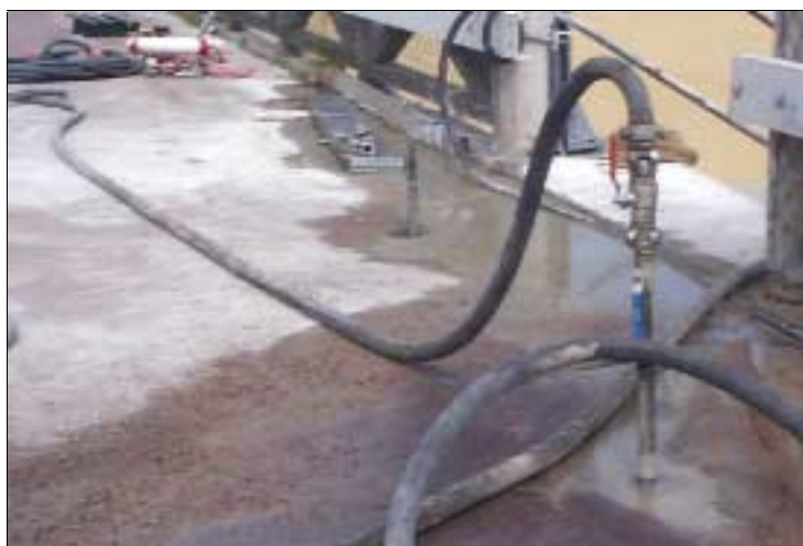
Figur 5.4 Fotografi som visar en pågående injektering av en pelarnos.
