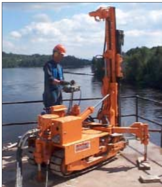
Figur 5.2 Den borrhög som har använts i Forshuvud för att borra injekteringsborrhål (hammarborrning).
