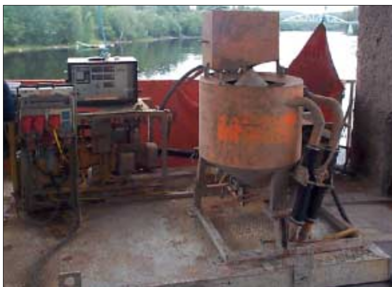
Figur 5.3 Injekteringsplattform med kolloidkvarn, pump och utrustning för tryck- och flödesmätning.
