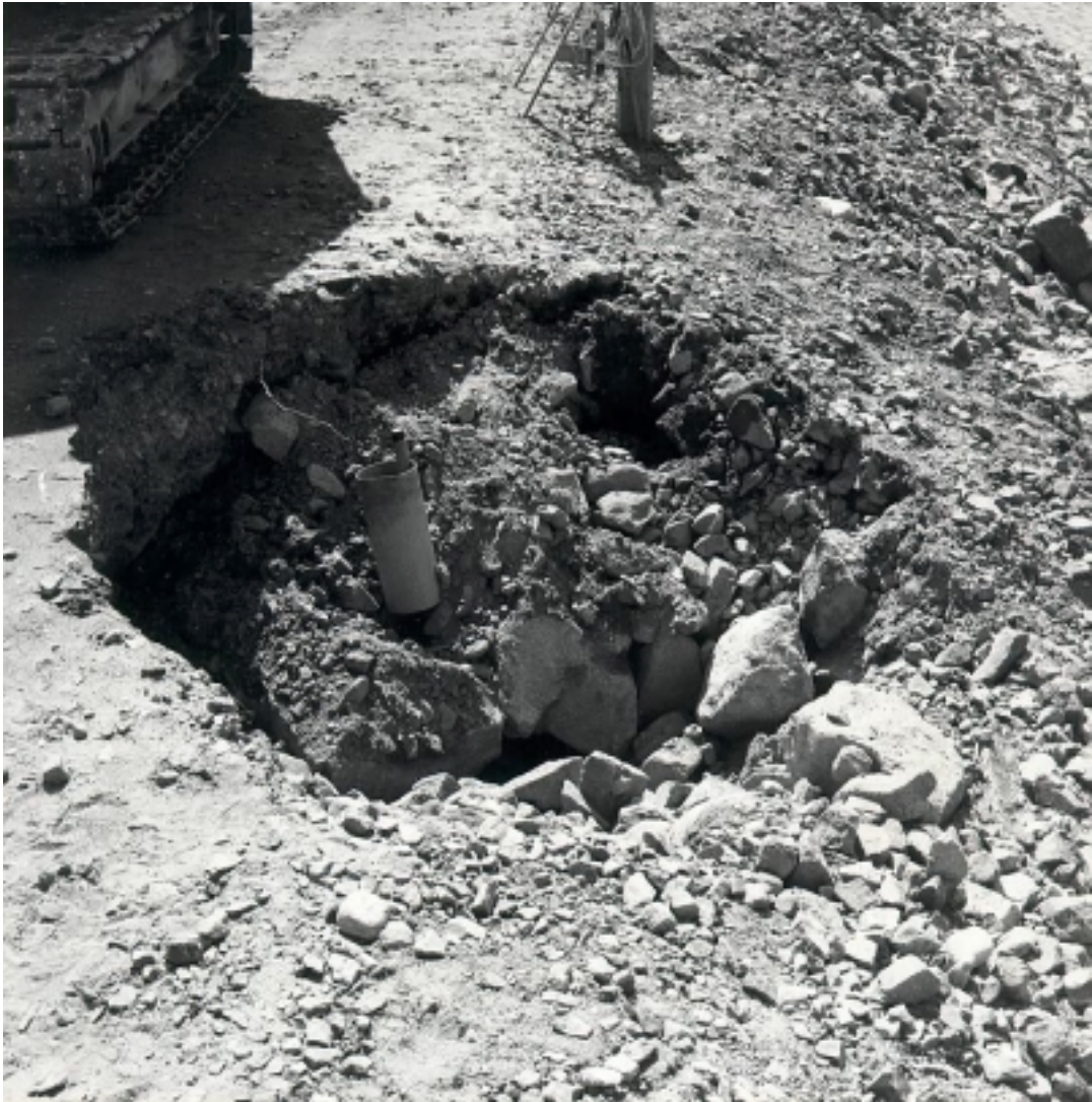
Figur 12 Sjunghål sektion 1/860 sommaren 1964 / Sink-hole at section 1/860 summer of 1964
