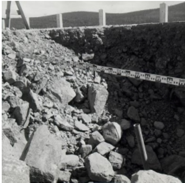
Figur 9C Sjunkhål i sektion 1/737 augusti 1963 / Sink-hole at section 1/737 August 1963
