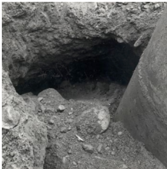
Figur 9D Sjunkhål i sektion 1/780 augusti 1963 / Sink-hole at section 1/780 August 1963
