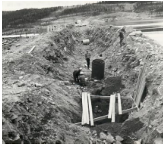
Figur 11A Återfyllning av morän på den uppschaktade delen av dammkrönet, runt sättningsställena höjdes tätkärnans krön avsevärt / Re-filling by moraine on the excavated part of the crest, the crest level was raised considerably adjacent to the settlements
