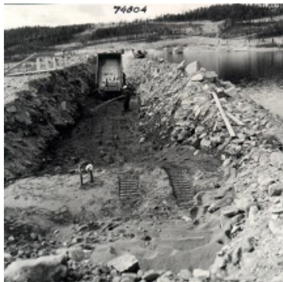
Figur 11B Återfyllning av morän på den uppschaktade delen av dammkrönet, runt sättningsställena höjdes tätkärnans krön avsevärt / Re-filling by moraine on the excavated part of the crest, the crest level was raised considerably adjacent to the settlements
