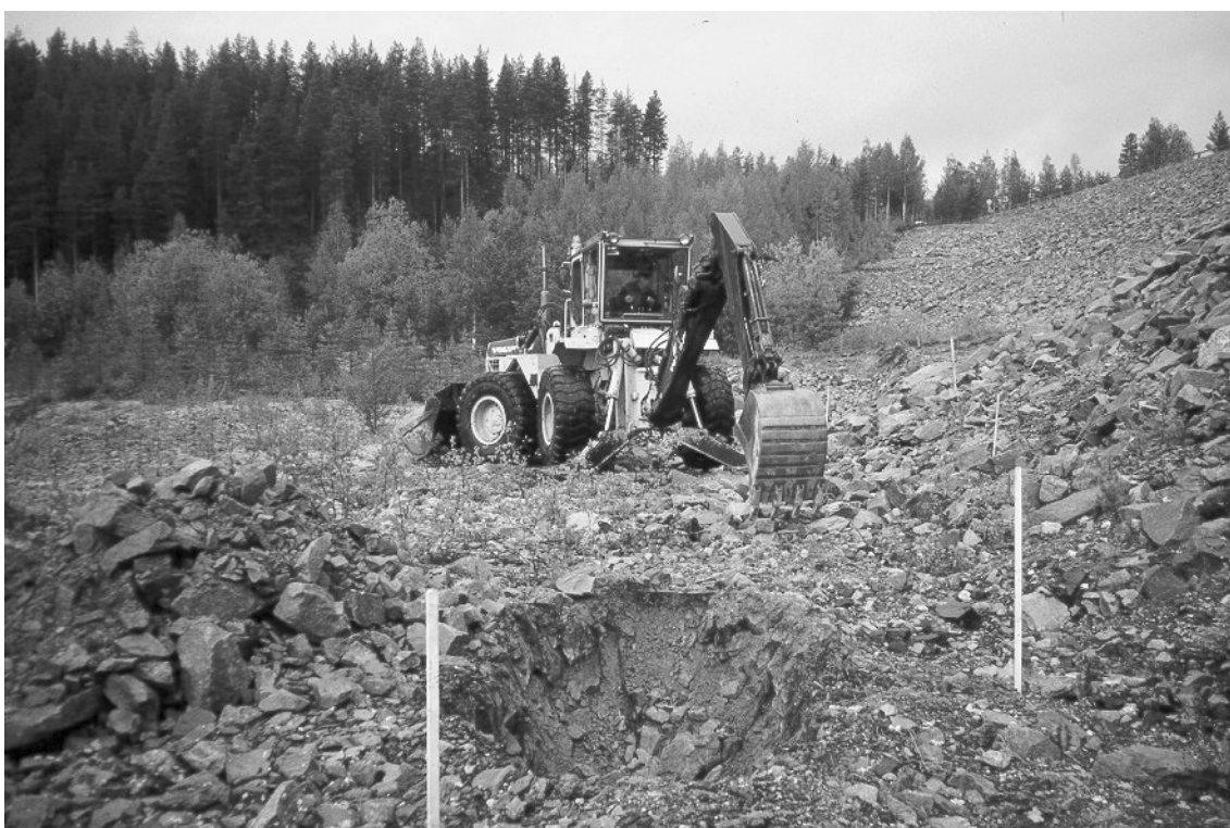
Figur 49. Grävning för installation av elektrod nedströms höger damm.
