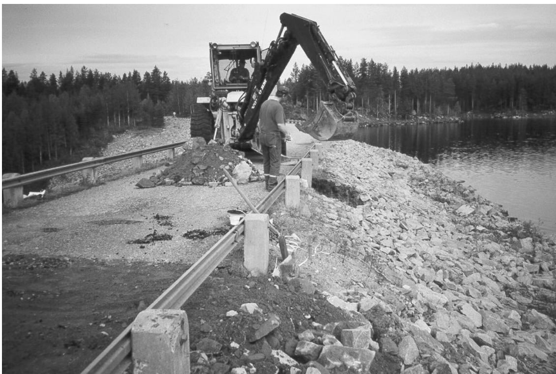
Figur 48. Grävning för installation av elektrod på höger dammkrön.
