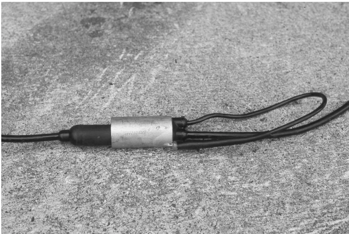
Figur 52. Detalj av elektrod kabel för undervattensinstallation med ringelektrod monterad.
