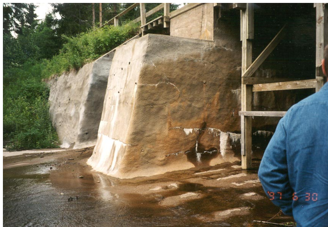
Figur 6.2. Exempel på injektering och betongsprutning av mitterpelare vid utskov.
