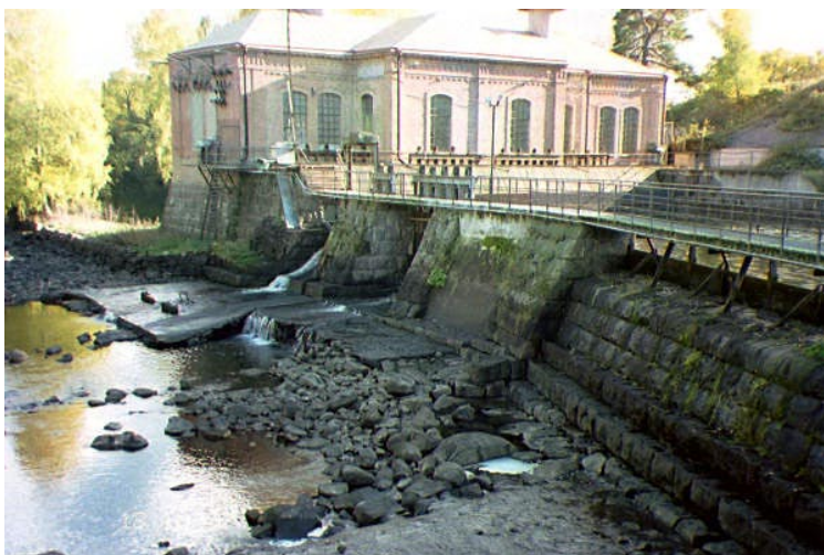
Foto av kraftstation i Nykvarn i Motalaström
