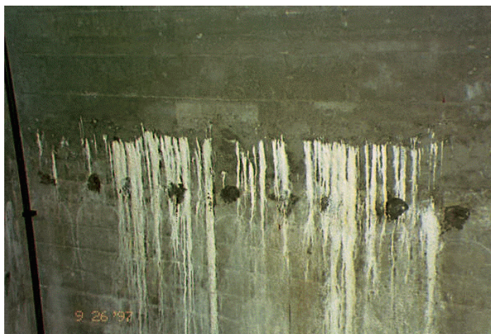
Figur 6.1. Exempel på injektering i uppströmsvägg.
