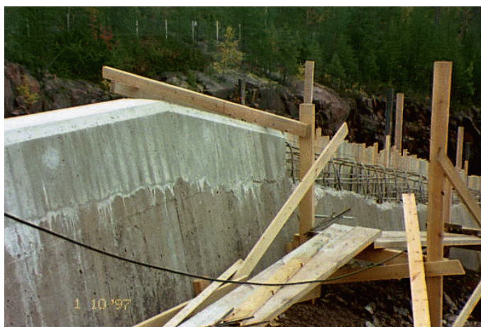
Figur 6.3. Exempel på betonggjutning av stödmur vid utskov.
