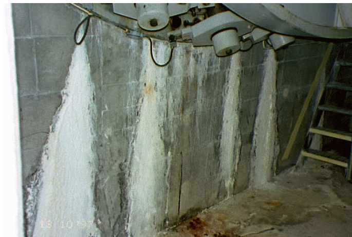
Figur 5.4 Exempel på urlakning av betong i uppströmsvägg vid intag.
