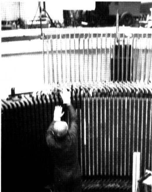
Omlindning av stator
