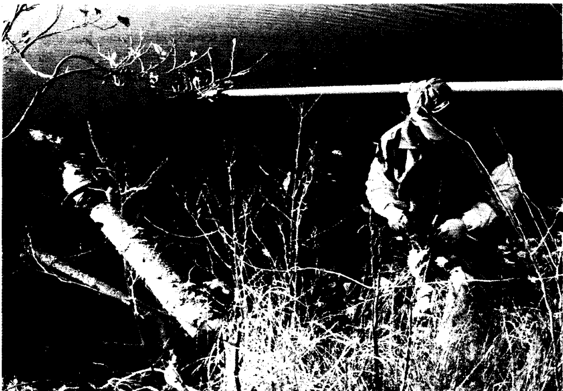
Bild 13. Sprängklämman fäst på stocken i vattnet.
