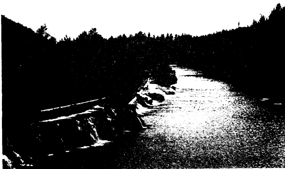
Foto 5. Överströmning till utloppskanalen vid 200 m 3 /sek i spill
