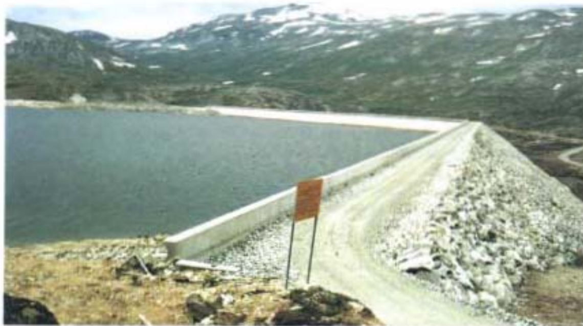
Figur 4.6. Vågskydd (parapet) för att undvika överspolning av dammkrön.
