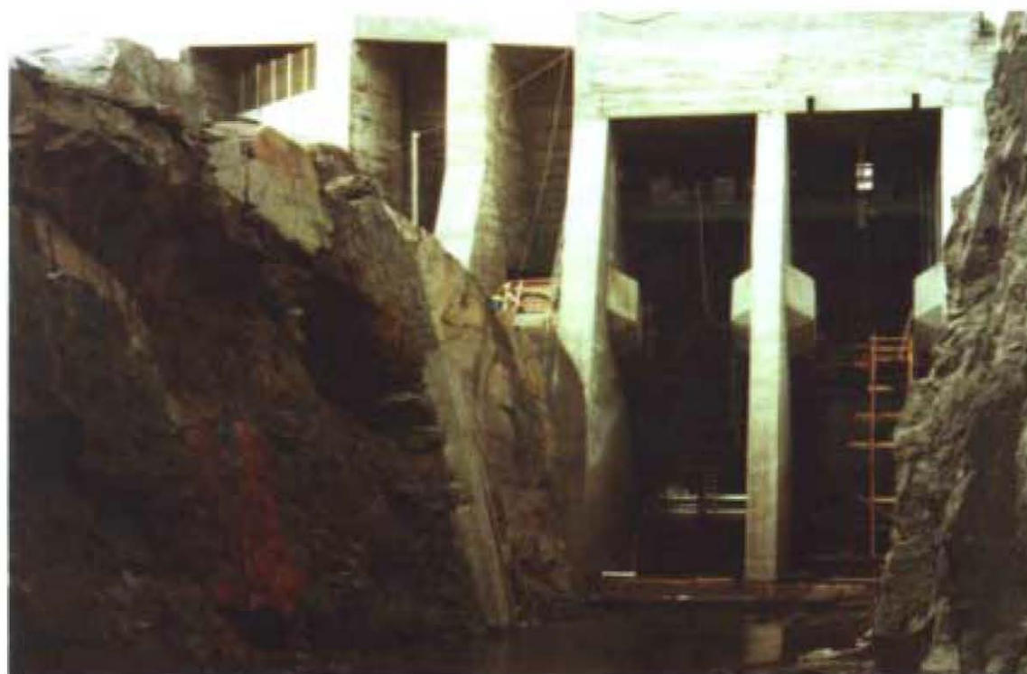
Figur 6.10. Utskov med skador i berg vid sidorna efter provtappning.
