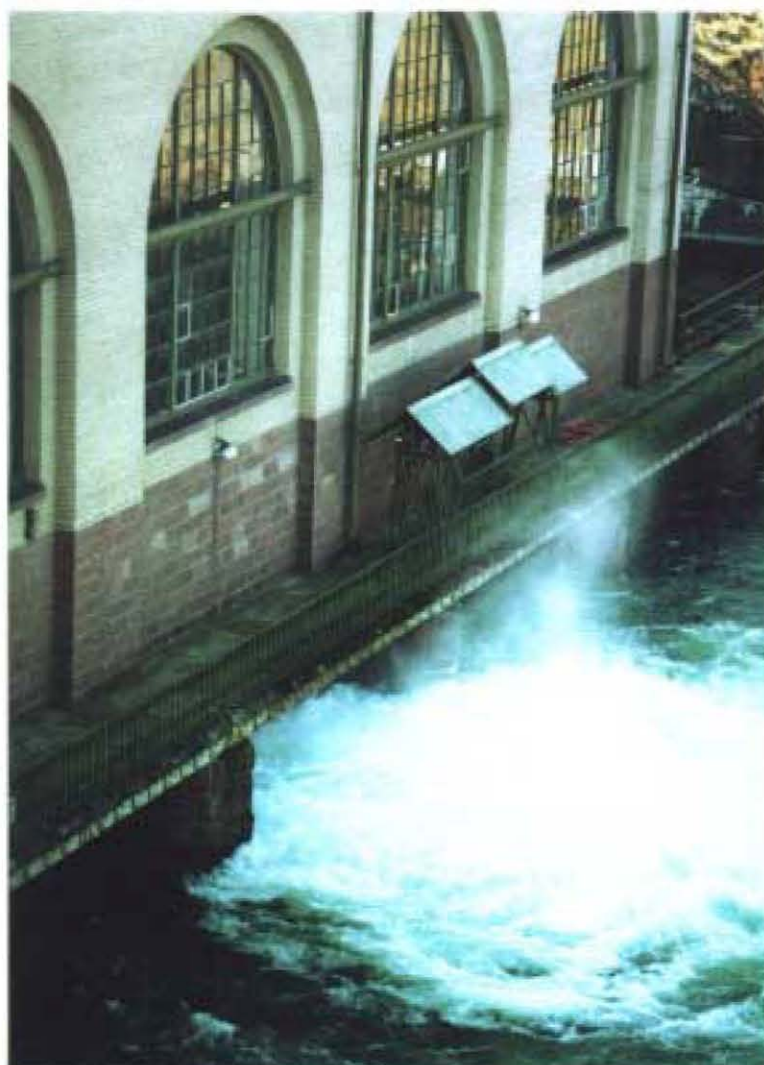
Figur 6.3. Provtappning i Motala kraftstation (inga skador).
