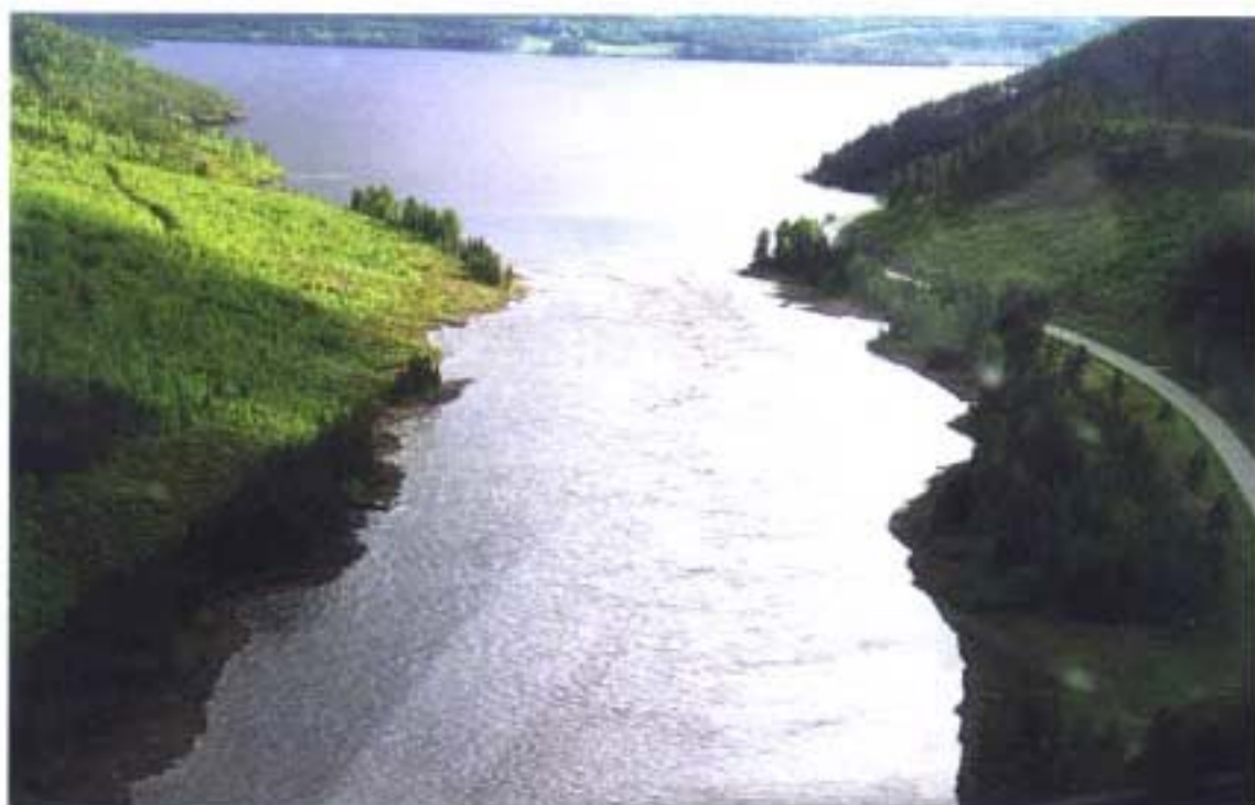
Figur 3.3. Bilden visar fallförluster under högt flöde vid utloppet ur Gesunden. Vid normalt flöde är det samma vattennivå fram till Krångede kraftverk 1 km nedströms.
