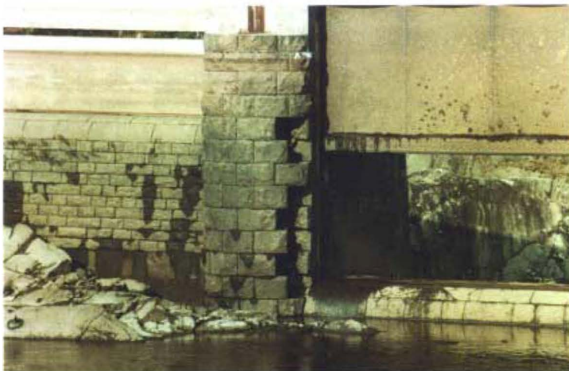
Fig 8.5. Utskovspelare med försvunna stenar.
