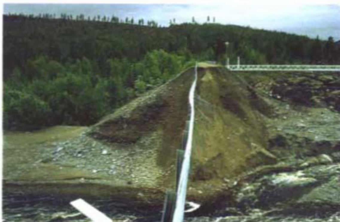
Figur 3.7. Under den regnriska hösten 1985 hade grundvattennivån i Dalarna höjts över den normala. När sedan ett våldsamt, långvarigt regn inträffade och dessutom ett av utskoven i Noppikoski havererade, överdämades jorrdammen med dammbrott som följd, varvid magasinet på 1 Mm 3 tömdes inom mindre än en timme. Flödet orsakade skador inom några mils sträcka längs älven.
