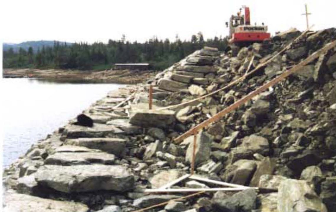
Figur 4.4. Utförande av erosionsskydd med ytlager av stabilt ordnade långsmala block.
