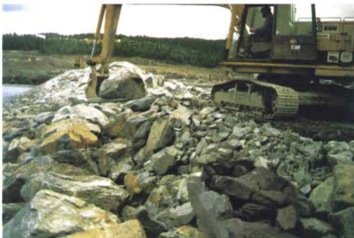
Figur 4.3. Utläggning av block i uppströms erosionsskydd med grävmaskin vid nybyggnad av stenfyllningsdamm.
