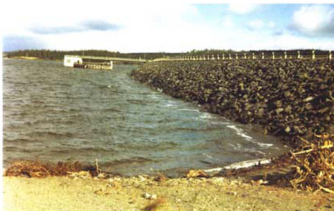
Figur 4.5. Erosionsskydd med ytlager av oordnad fyllning.
