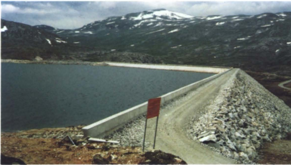
Bild 4.6. Vågskydd (parapet) för att undvika överspolning av dammkrön.
