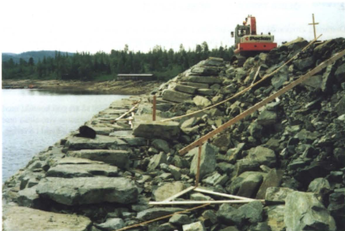
Bild 2.1. Utförande av erosionsskydd med ytlager av stabilt ordnade långsmala block.
