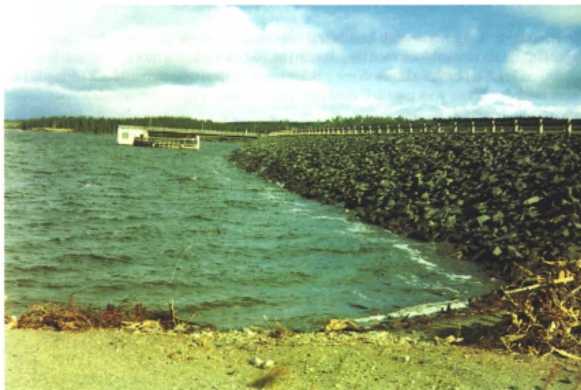
Bild 2.2. Erosionsskydd med ytlager av oordnad fyllning.
