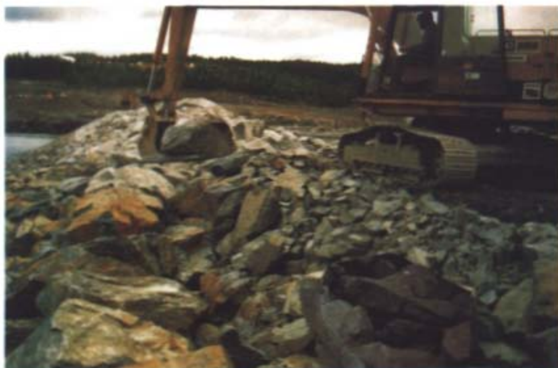
Bild 4.1. Utläggning av block i uppströms erosionsskydd med grävmaskin vid nybyggnad av stenfyllningsdamm. Bilden visar damm i Norge under uppförande.
