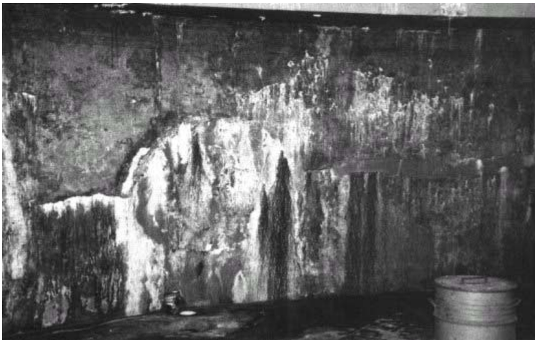
Figur 3.2 Kalkavlagringar på vägg.
