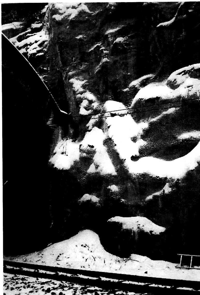
Figur 4.3 Förskränning till järnvägstunnel i Graversfors. Open cut to the Graversfors railway tunnel.
