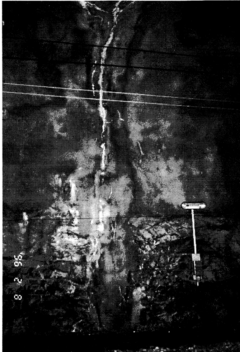
Figur 4.6 Detalj av drän med sprickbildning och kalkutfällning som självläkt. Detail of drain with cracking and limedeposits causing "self-healing".
