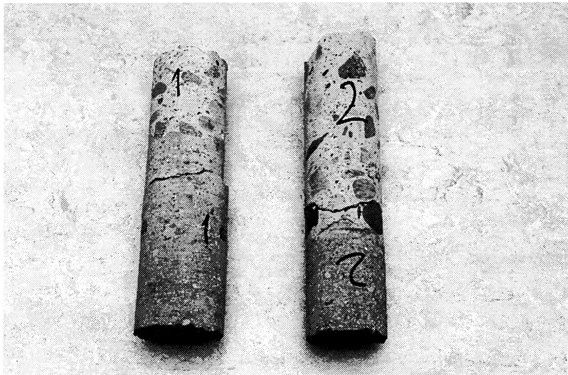
Figur 4.14 Borrkärnor från pelare i bro över E4 vid Stora Åby, Ödeshög. Drill cores from pillar in bridge over E4 at Stora Åby, Ödeshög.
