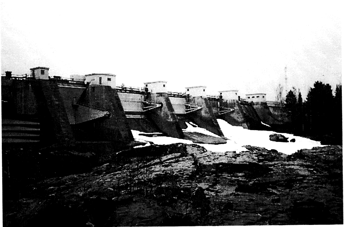
Figur 4.22 Utskov vid Stadsforsens kraftstation, Indalsälven Spillways at the Stadsforsen power plant, in the river Indalsälven
