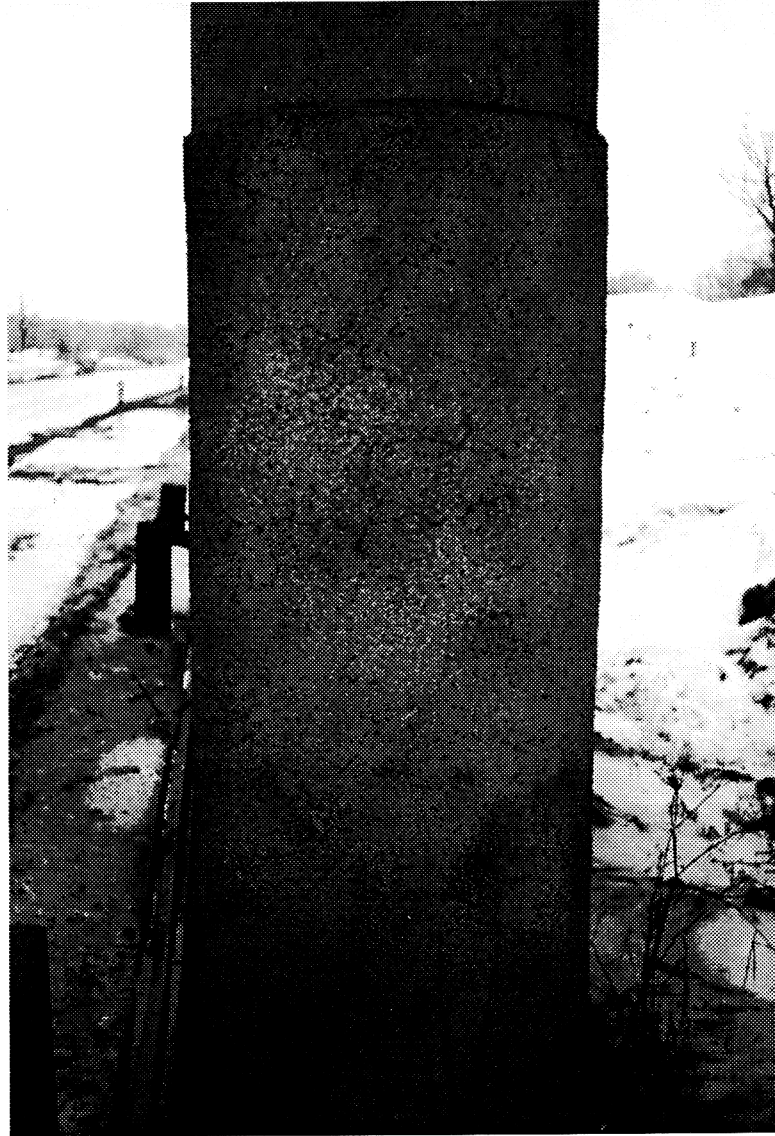
Figur 4.13 Krackelering på pelare, E4 Stora Åby, Ödeshög. Crackle on pillar, E4 at Stora Åby, Ödeshög.
