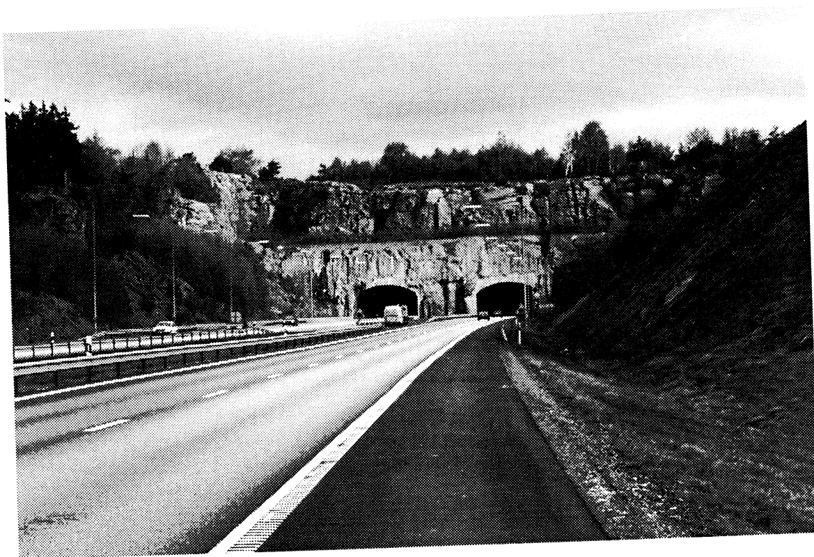
Figur 4.9 Södra mynningen av Viskantunneln, E6 Varberg. South mouth of the Viskan tunnel, E6 Varberg.
