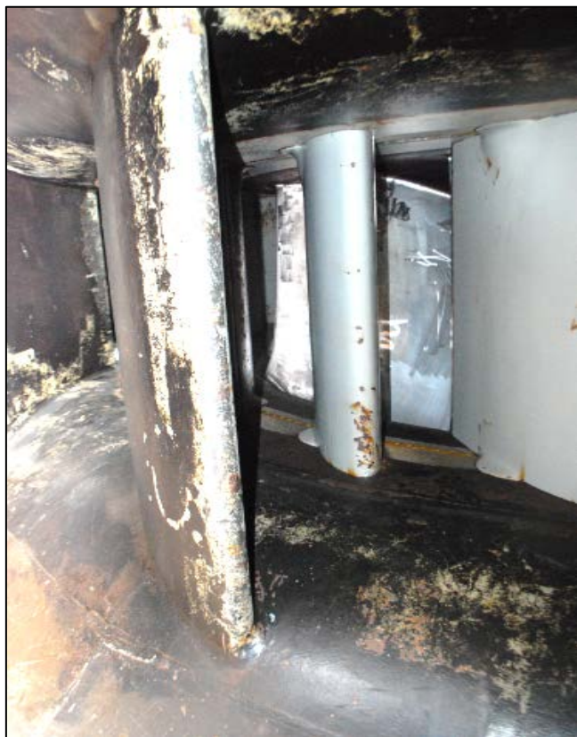
Figur 7.9 Ytskikt på stagpelare i spiralen är delvis nednötta. Lägg märke till turbinbladen som kan skymtas innanför ledskenorna.
