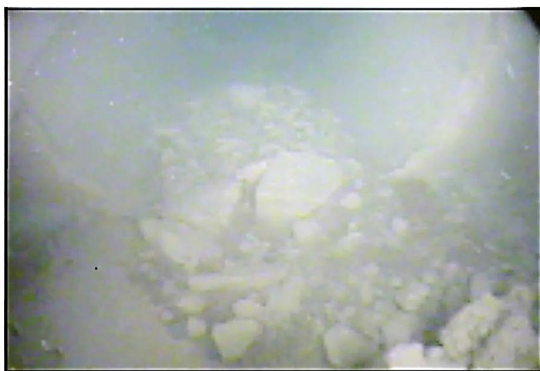
Figur 7.29 Bild från tillloppstunnel till bassängen som visar avlagringar från tidigare modellförsök i hallen.
