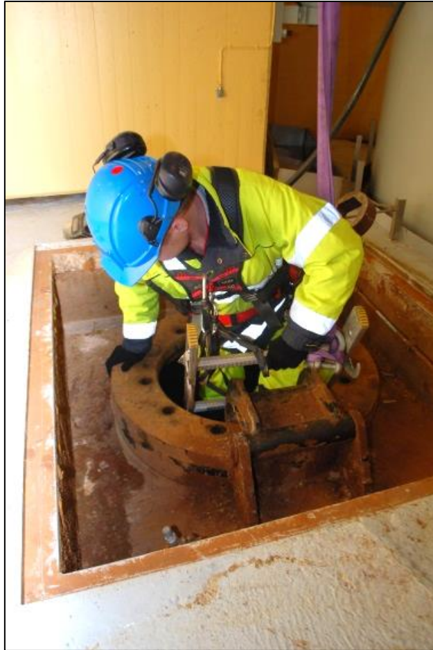
Figur 7.4 Tillträdeslucka för spiralen.
