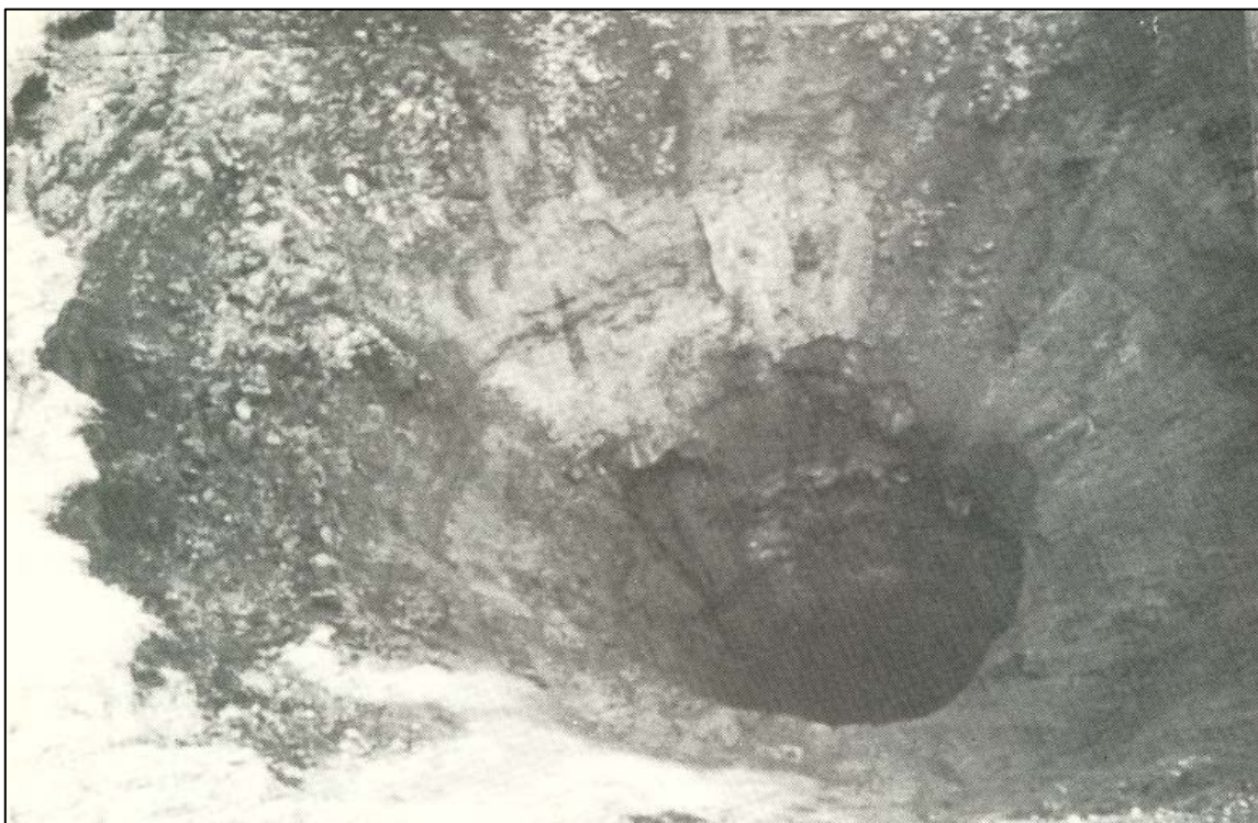
Figur 4.6 Rashålet vid Gidböle som var ca 12 meter i diameter (Hultman, Stille & Söder, 1993).
