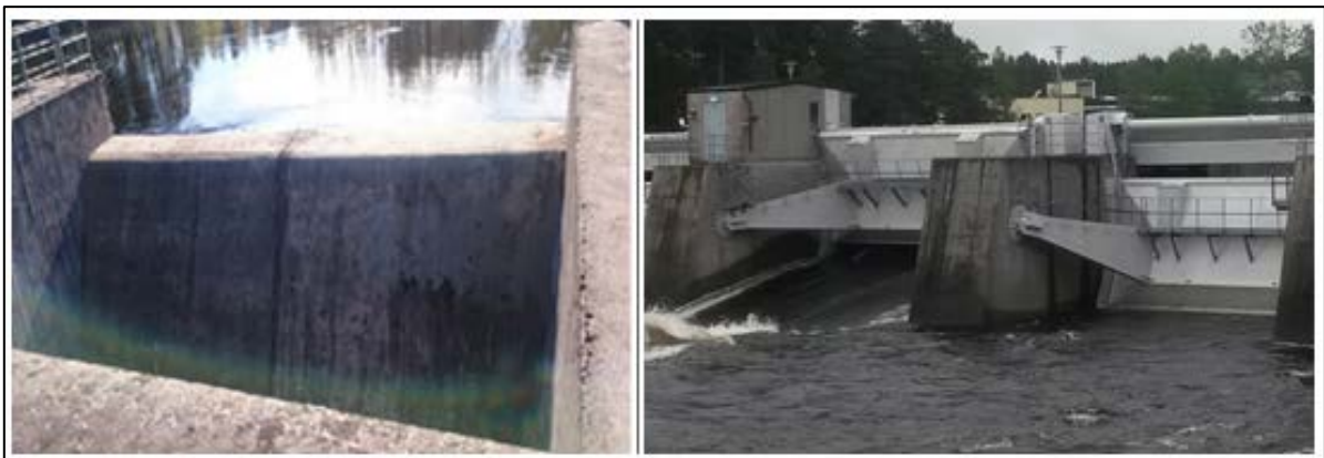
Figur 2.6 Två olika utskov. T.v. ett överflödesutskov och t.h. två segmentluckor där det vänstra är öppet och vatten släpps igenom.
