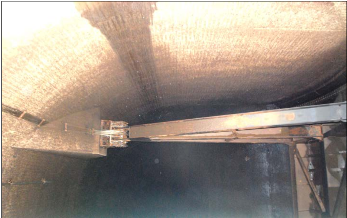
Figur 7.6 Tiloppstuben uppifrån, 100 meter rakt ner. Stålbalkarna som syns på bilden tillhör intagsluckan.
