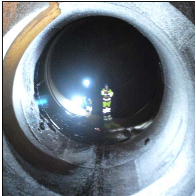
Figur 7.5 Övergången mellan tilloppstuben och spiralen. Bilden är tagen från tuben mot spiralen.
