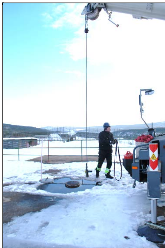
Figur 7.7 Byggnaden ovanför tiloppstuben. Genom hålet mitt på bilden löpte kranens vajer som hissade korgen upp och ner i tilltoppstuben.
