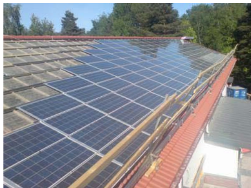
Figur 1.6 Takintegrering med Solrif där solcellerna ersätter de ordinarie takpannorna.
