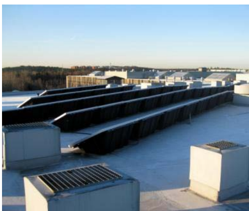
Figur 4.3 Modulerna är installerade i ett montagesystem av plast från det holländska företaget Ubbink Solar/Renusol. Systemet, som heter Console, möjliggör ett montage utan ingrepp i takytan.
