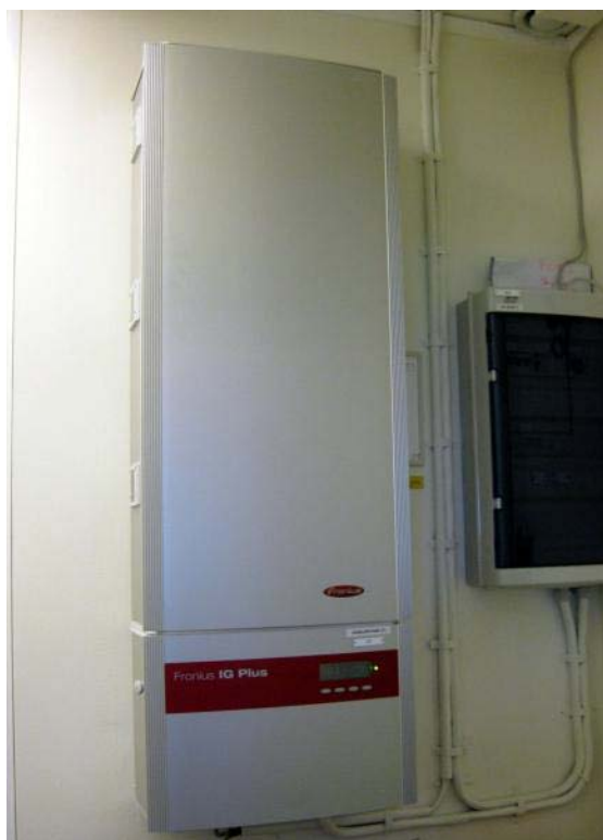
Figur 2.1 En växelriktare Fronius IG Plus 150 räcker för 13 kW toppeffekt på Bua kyrka.
