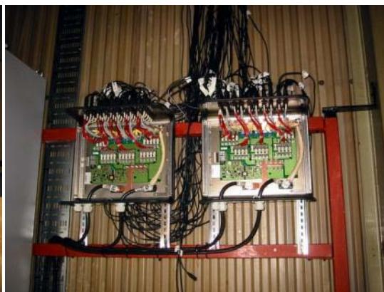
Figur 4.8 Samtliga modulsträngar parallellkopplas i två "string controllers".
