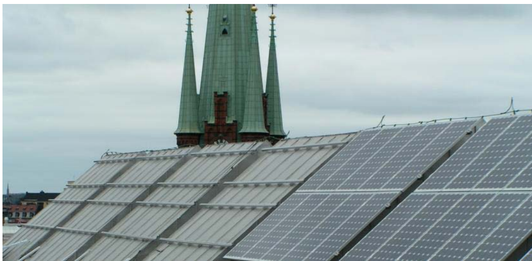
Figur 2.4 Falsat plåttak med klämmor och Intersol-monteringssystem på Stadsteatern i Stockholm.
