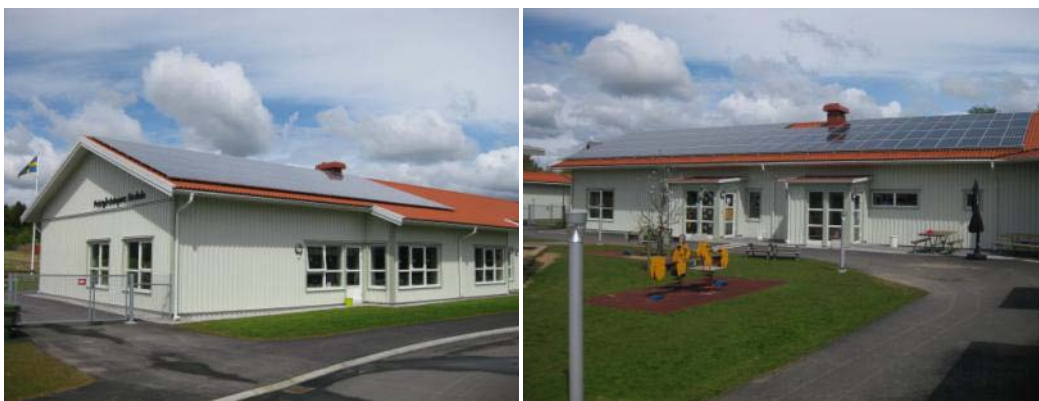
Figur 4.24 31kW installerat på Sveriges energieffektivaste förskola.
