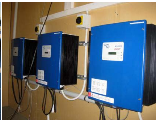
Figur 4.2 De tre växelriktarna är tillverkade av SMA och har beteckningen SB4200TL, där TL står för "transformerless" – transformatorlös för en högre verkningsgrad.
