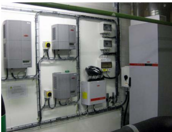
Figur 4.14 En centralväxlariktare och tre mindre modeller av Fronius IG. En "string controller" ingår i systemet.
