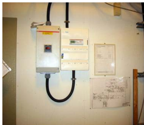
Figur 4.9 Anläggning ansluts till elnätet, 3x63 A. Figur 4.10 AC-brytare och elmätare.
