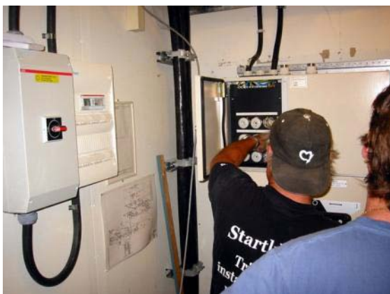
Figur 4.9 Anläggning ansluts till elnätet, 3x63 A. Figur 4.10 AC-brytare och elmätare.
