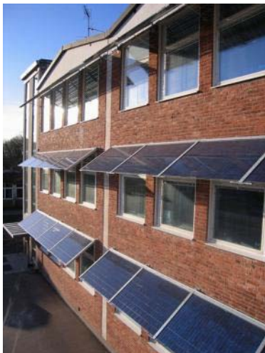
Figur 1.3 Mellanhedsskolan i Malmö är ett exempel på solavskärmning.
