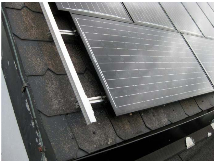
Figur 4.21 Svarta monokristallina kiselceller, svart tedlar på baksidan och svarta aluminiumramar – även montageprofilerna hade kunnat vara svarta!
