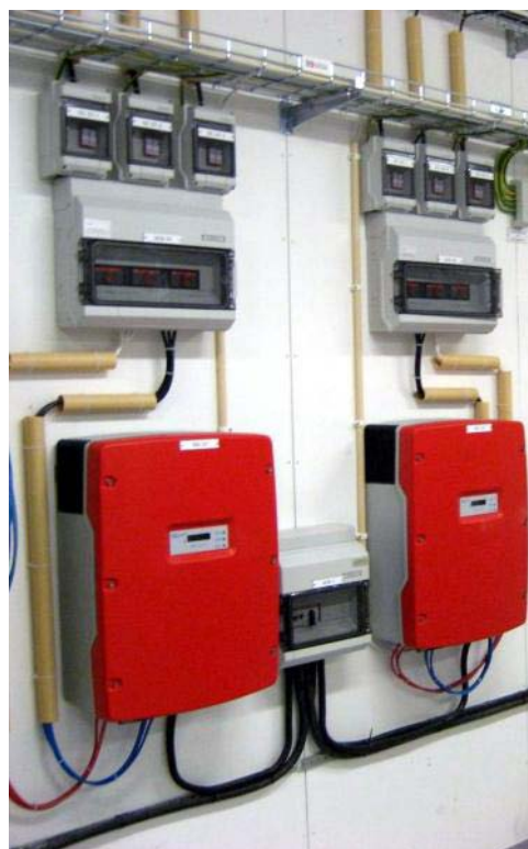
Figur 2.2 I anläggningen på Bjurhovdaskolan i Västerås används bla Sunny Mini Central, SMC 8000TL.
