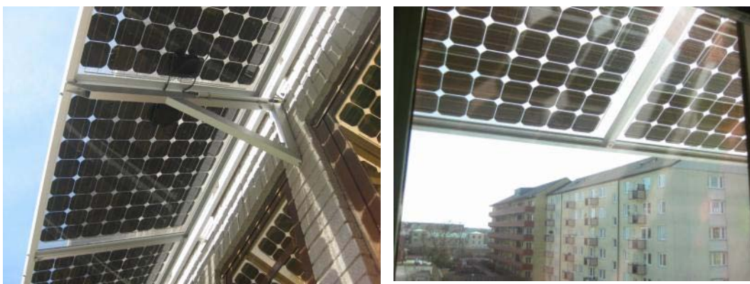
Figur 4.17 Den semitransparenta glas/glas-modulen ger ett skuggmönster men gör också att man upplever solavskärmningen som "luftigare" än vad en heltäckt modulbaksida skulle göra.
