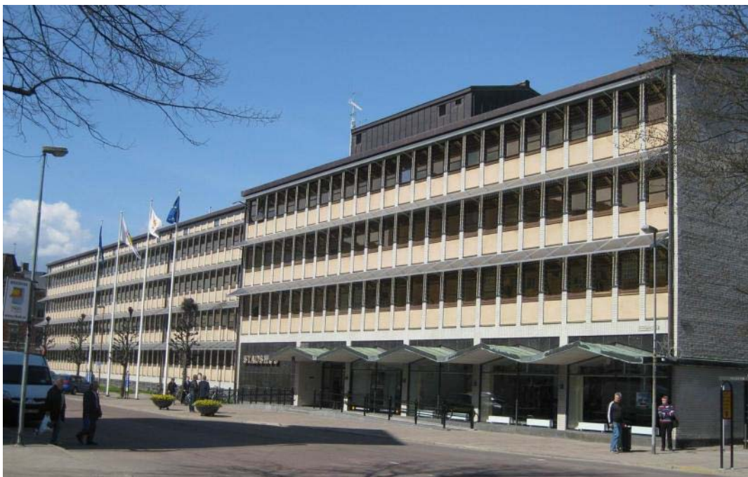
Figur 4.16 41 kW solceller i en solavskärmning på stadshusets sydfasad.
